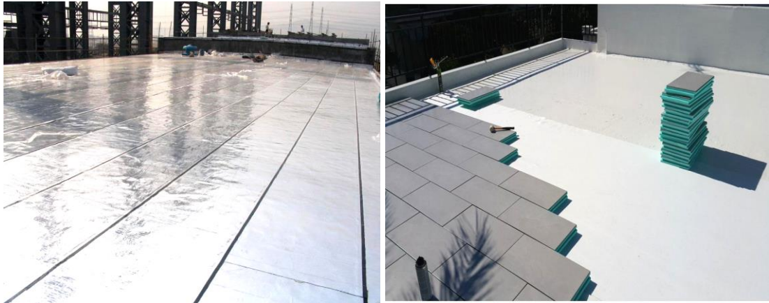
Εικόνα 9.5 Αδιάβροχα ασφαλτόπανα ταράτσας με πρόσψη αλουμινίου Εικόνα 9.6 Πλάκες πολυεστερικό γεώφασμα
