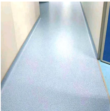
Εικόνες 4.29, 4.30 4.31 Δάπεδο χειρουργείου από PVC με κυρτές "γωνίες" Σκιαλυτικές λυχνίες & Ακτινολογικό σύστημα χειρουργείου
