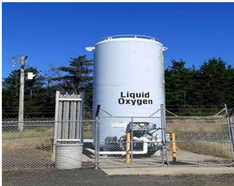
Εικόνα 8.4 Εγκατάσταση ιατρικού οξυγόνου έξωθεν νοσοκομείου. Λαμβάνει μέτρα ασφαλείας από πυρκαγιά, διαρροή και ανατίναξη με σήμανση συναγερμούς, ανιχνευτές αερίων, απώλειας πίεσης και περιμετρική περίφραξη
