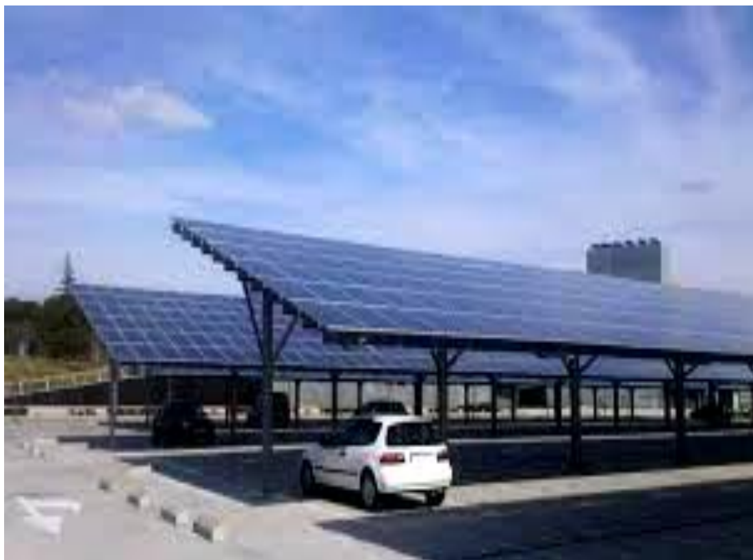
Εικόνα 3.1 Επένδυση των υποστέγων σε χώρο στάθμευσης με ηλιακά πάνελ. Γενικό Νοσοκομείο Καλαμάτας
