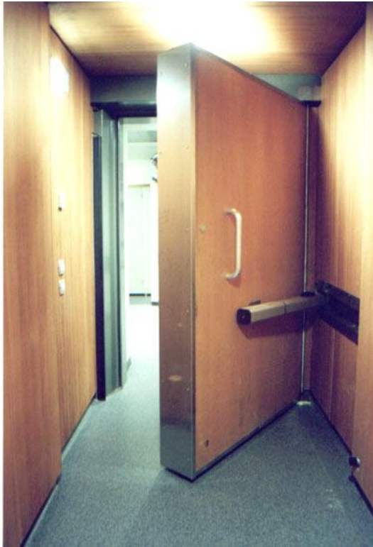
Εικόνα 11.7 Πόρτα επενδυμένη με μόλυβδο Εικόνα 11.8 Μολύβδινη επένδυση πατώματος
