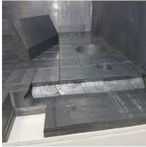
Εικόνα 11.7 Πόρτα επενδυμένη με μόλυβδο Εικόνα 11.8 Μολύβδινη επένδυση πατώματος
