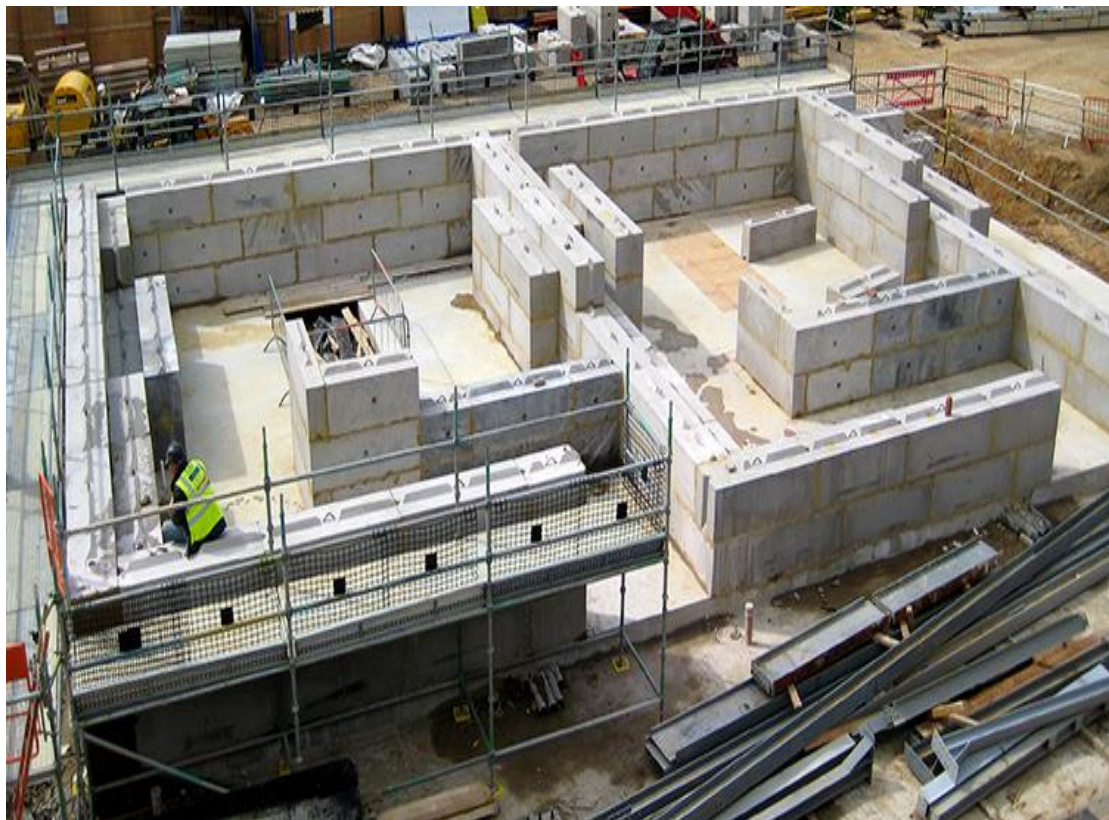
Εικόνα 5.2 Προετοιμασία δαπέδου και τοιχοποιίας και λαβυρινθοποίηση στο υπόγειο νοσοκομείου που θα δεχτεί γραμμικό επιταχυντή.
