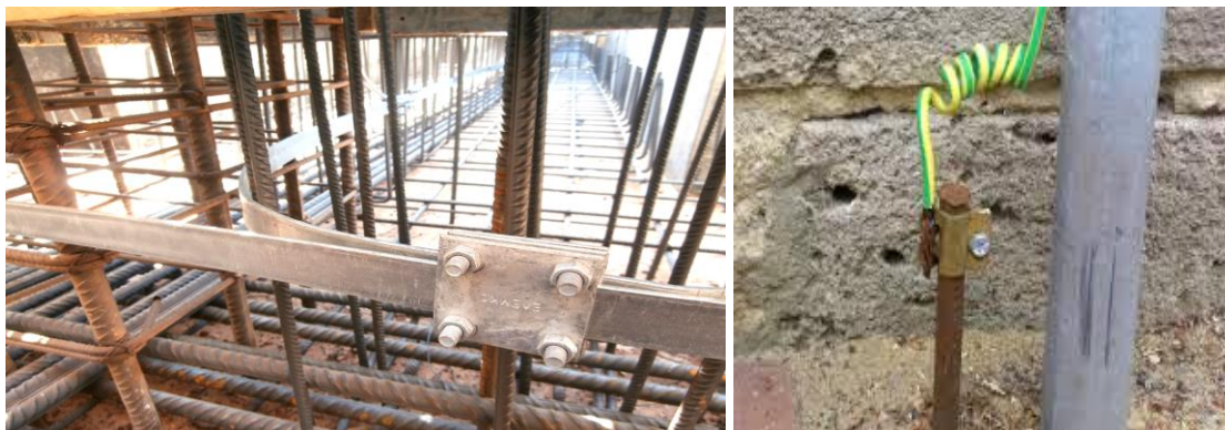
Εικόνα 11.1 Ταινιοειδείς αγωγοί γείωσης στα θεμέλια λίγο πριν την σκυροδέτηση
