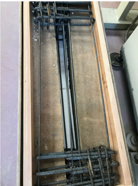
Εικόνα 6.4.1.3 Κατασκευή δοκιμίου TS02(20/2/2023)
