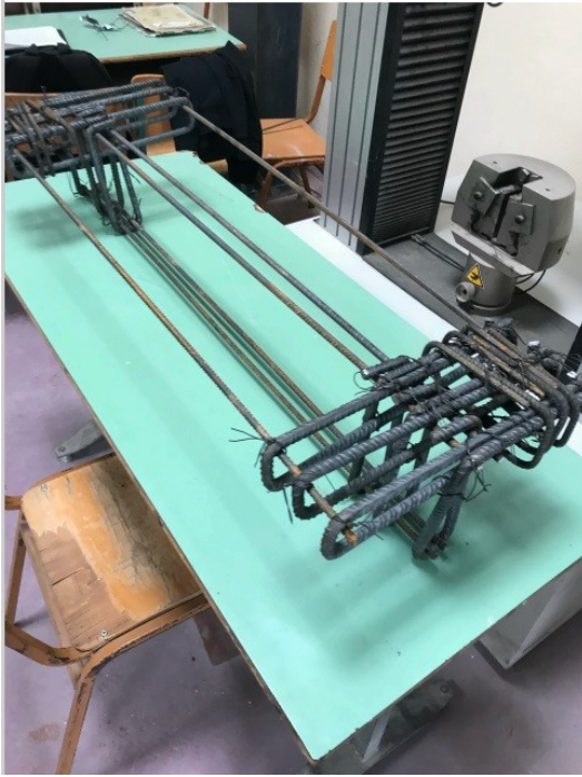
Εικόνα 6.4.1.4 Κατασκευή δοκιμίου TS03 (25/2/2023)
