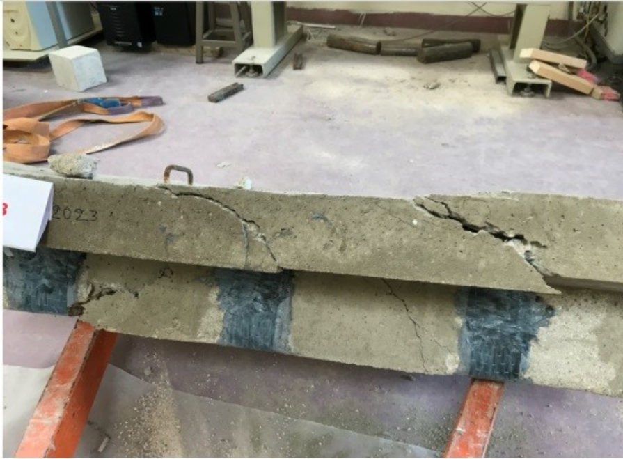
Εικόνα 6.4.1.9 Κατάσταση δοκού μετά την εφαρμογή φορτίου (δοκίμιο TS01)
