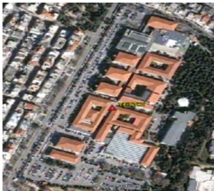
Εικόνα 29 Η θέση του μόνιμου σταθμού
