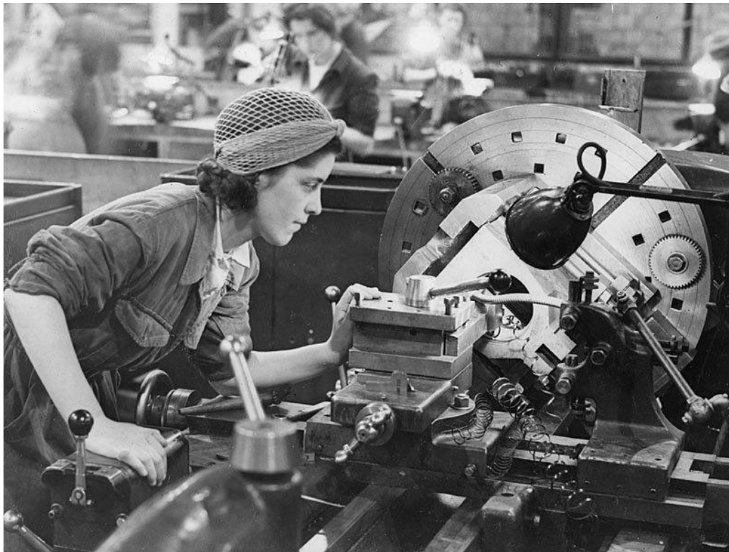
Εικόνα 1: Εργαζόμενη σε Βιομηχανικό χώρο εκτεθειμένη σε κίνδυνο (Φωτογραφικό αρχείο Δ.Ε.Η. Α.Ε.)
