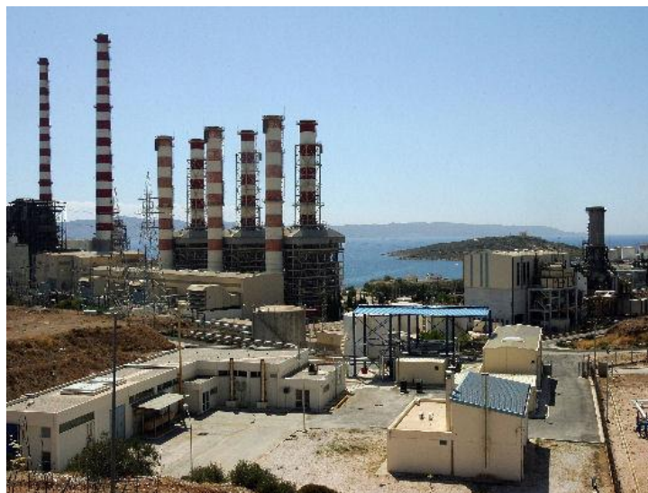
Εικόνα 17: Εσωτερική φωτογραφία του ΑΗΣ Κερατέας - Λαυρίου με τις αποσυρμένες μονάδες (Προσωπικό φωτογραφικό αρχείο)
