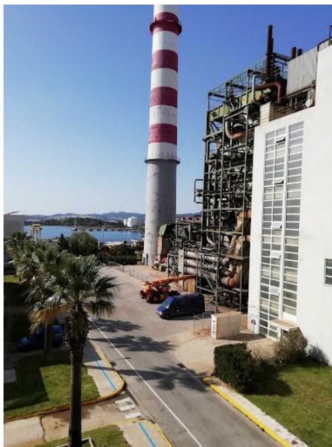
Εικόνα 24: Εσωτερικό του ΑΗΣ Κερατέας- Λαυρίου (Google Images, ΔΕΗ ΑΗΣ ΚΕΡΑΤΕΑΣ/ΛΑΥΡΙΟΥ )
