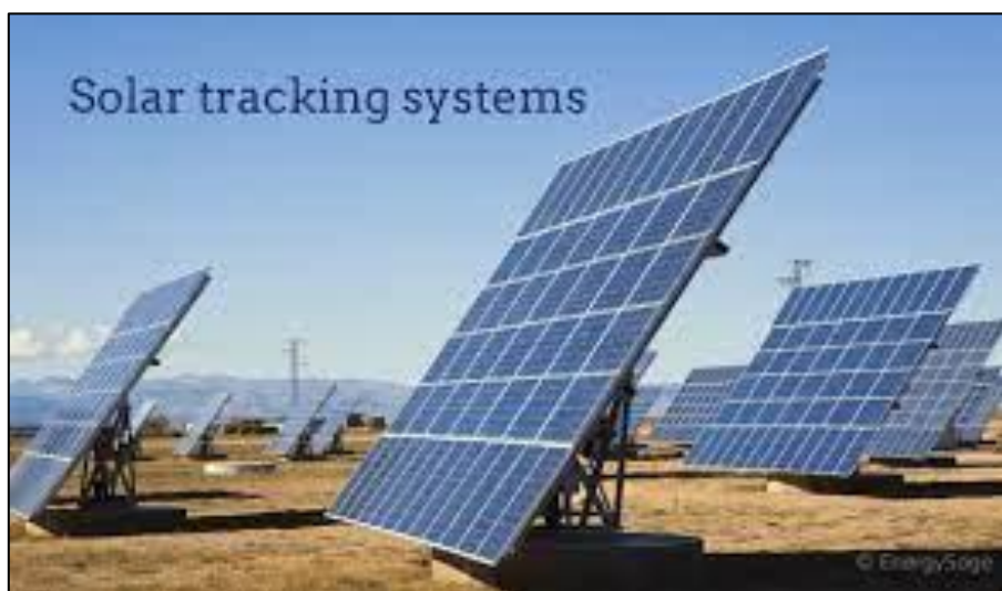
Εικόνα 18: Φωτοβολταϊκό με σύστημα παρακολούθησής της θέσης του ήλιου με σκοπό την βελτιστοποίηση απορρόφησης της διαθέσιμης ηλιακής ακτινοβολίας. (“Solar tracker | Definition & Facts | Britannica,” 2023)
