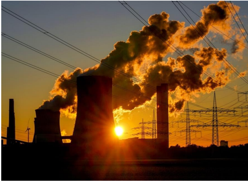
[04] Καυσαέρια από σταθμό παραγωγής ηλεκτρικής ενέργειας
