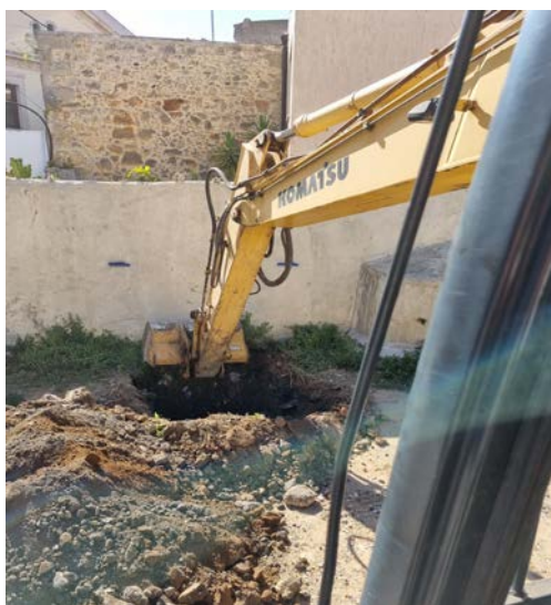
Εικόνα 195 Εκσκαφή θεμελίωσης και ντουλαπιών
