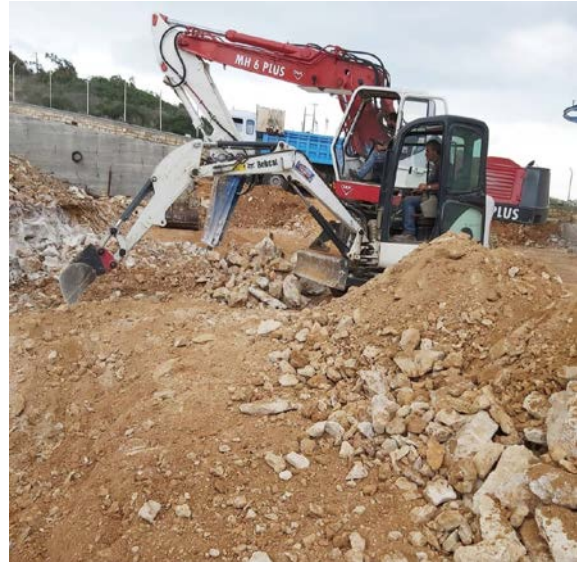
Εικόνα 234 Εκσκαφή μεταλλικής κατασκευής
