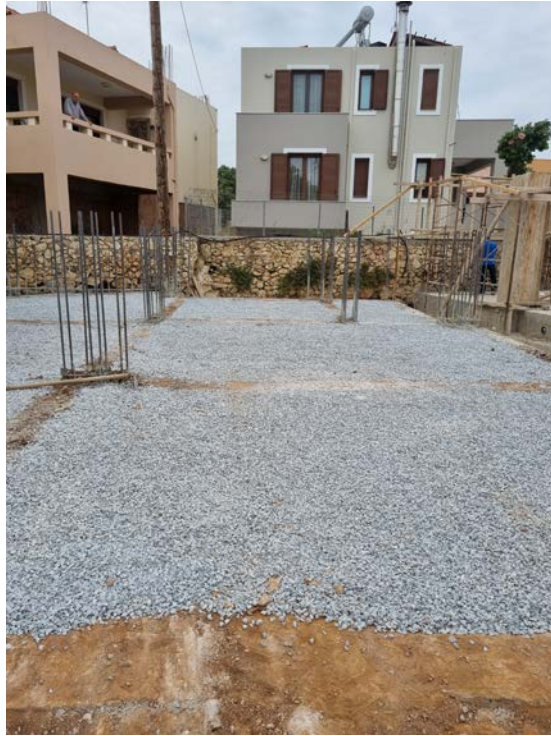
Εικόνα 206 Μπάζωμα θεμελίωσης
