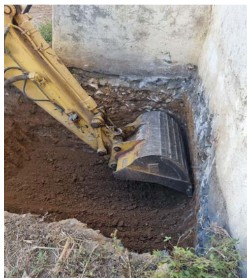
Εικόνα 196 Εκσκαφή θεμελίωσης και ντουλαπιών
