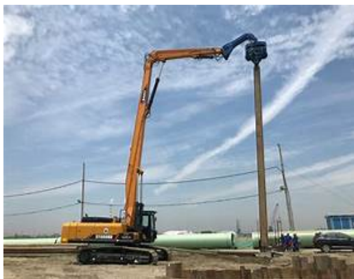
Εικόνα 67 Εκσκαφέας με πασσαλόπηκτη
