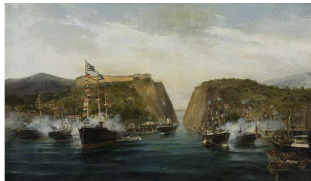
Εικόνα 2 Διώρυγα της Κορίνθου
