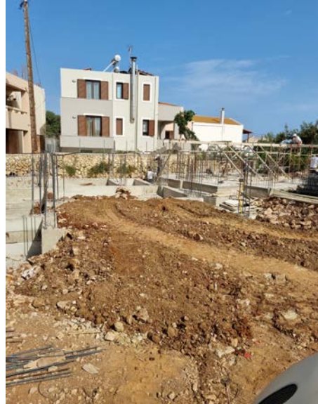
Εικόνα 203 Μπάζωμα θεμελίωσης
