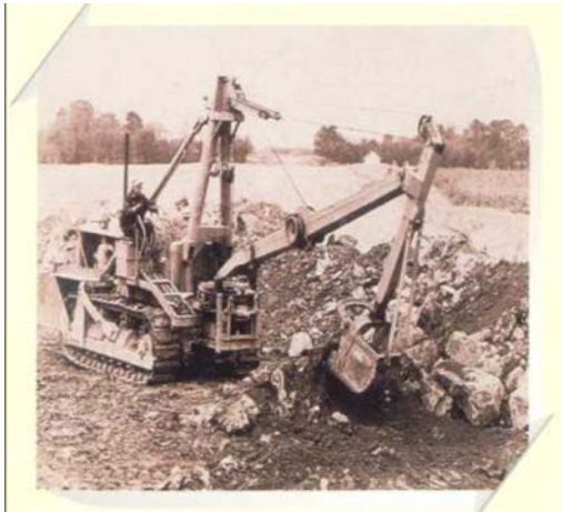
Εικόνα 25 Μηχάνημα με σύστημα εκσκαφής
