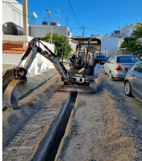
Εικόνα 188 Εξσκαφή μικρής τάφρου
