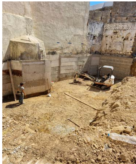
Εικόνα 200 Εκσκαφή θεμελίωσης και ντουλαπιών
