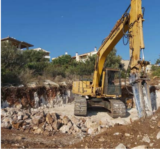
Εικόνα 241 Εκσκαφή με ανισόπεδα επίπεδα
