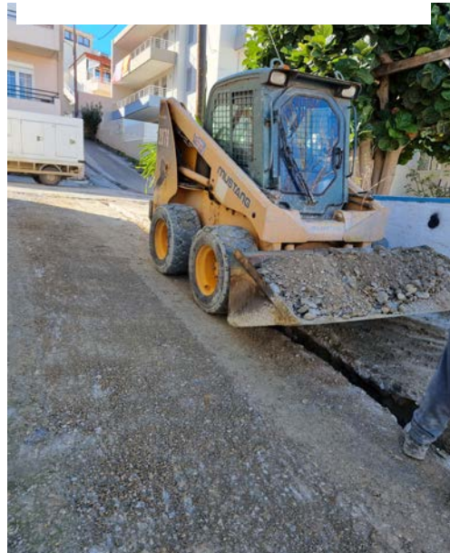
Εικόνα 190 Εξσκαφή μικρής τάφρου
