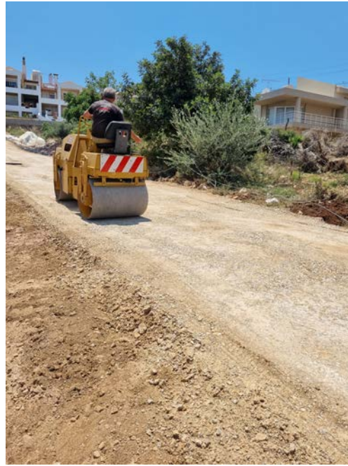
Εικόνα 217 Στρώσιμο δρόμου με υπόβαση 3ΑΒ
