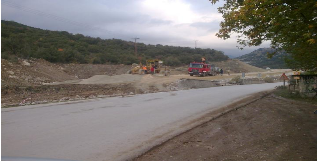
Εικόνα 58 Εργασίες στο τμήμα Χαλκίδας -Ψαχνών
