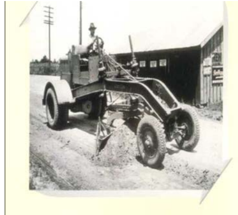
Εικόνα 18 Διαμορφωτής γαιών με κινητήρα και χειριστήρια
