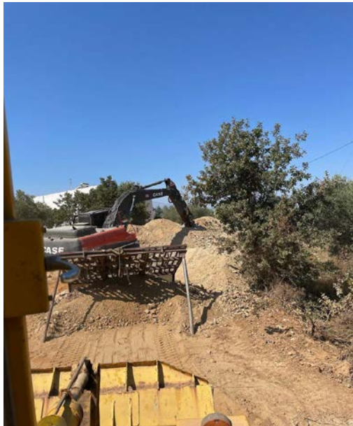
Εικόνα 230 Κοσκίνισμα υλικού
