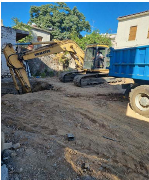
Εικόνα 193 Εκσκαφή θεμελίωσης και ντουλαπιών
