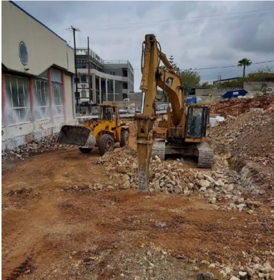
Εικόνα 233 Εκσκαφή μεταλλικής κατασκευής
