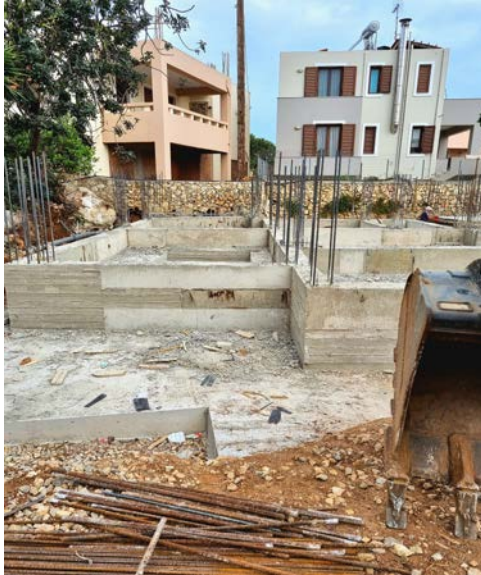
Εικόνα 202 Μπάζωμα θεμελίωσης
