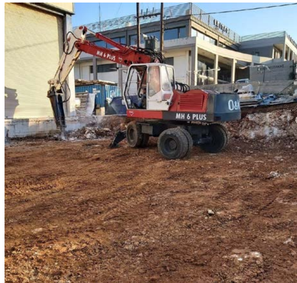
Εικόνα 236 Εκσκαφή μεταλλικής κατασκευής
