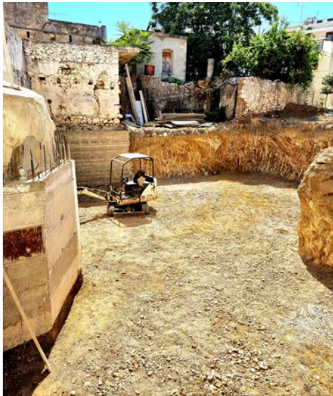
Εικόνα 199 Εκσκαφή θεμελίωσης και ντουλαπιών
