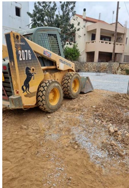
Εικόνα 205 Μπάζωμα θεμελίωσης
