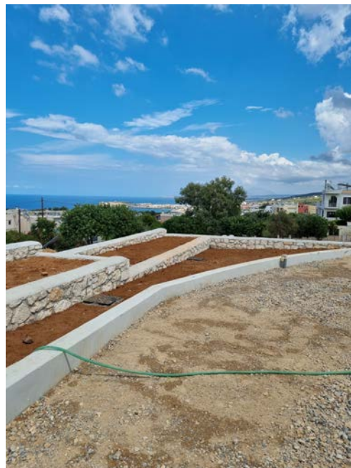
Εικόνα 211 Επιχωμάτωση και διαμόρφωση εξωτερικού χώρου
