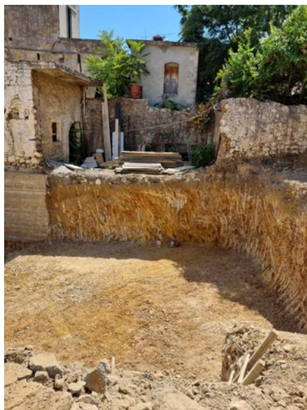
Εικόνα 201 Εκσκαφή θεμελίωσης και ντουλαπιών
