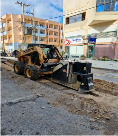
Εικόνα 187 Εξσκαφή μικρής τάφρου
