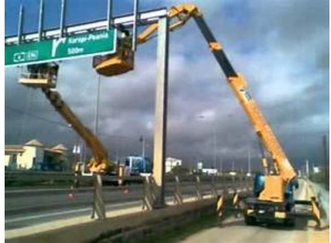
Εικόνα 177 Γερανός για επισκευή πινακίδων
