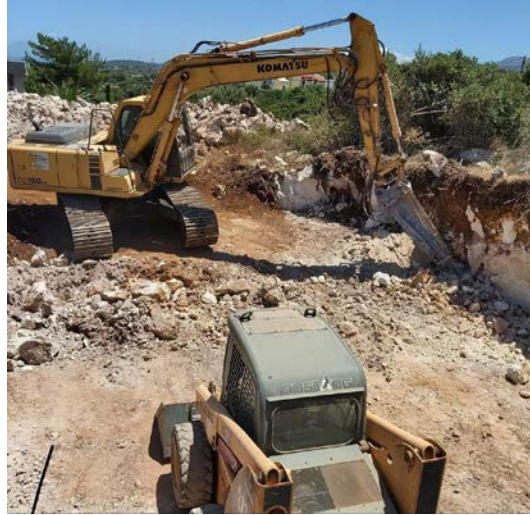
Εικόνα 242 Εκσκαφή με ανισόπεδα επίπεδα
