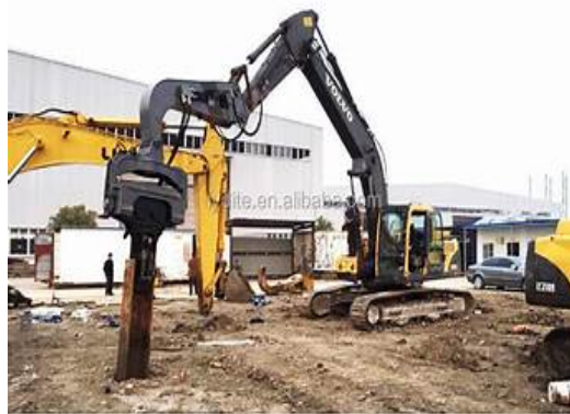
Εικόνα 68 Εκσκαφέας με πασσαλόπηκτη
