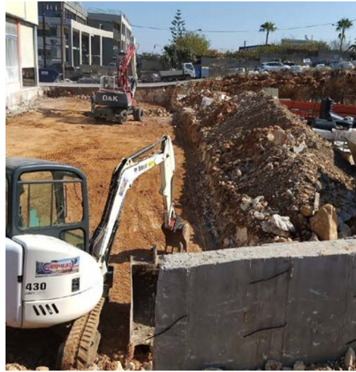
Εικόνα 238 Εκσκαφή μεταλλικής κατασκευής
