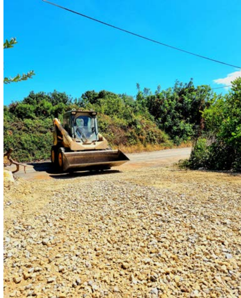
Εικόνα 213 Στρώσιμο δρόμου με υπόβαση 3Αβ
