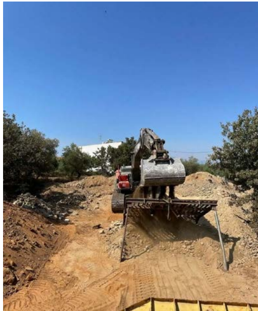
Εικόνα 231 Κοσκίνισμα υλικού
