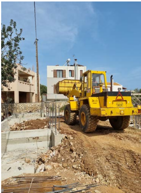
Εικόνα 204 Μπάζωμα θεμελίωσης
