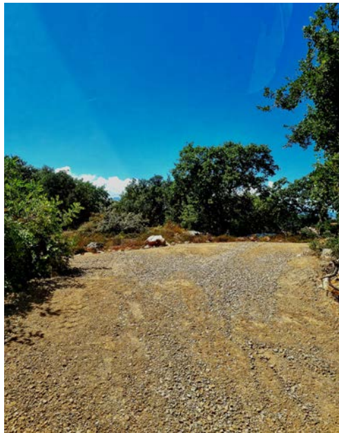
Εικόνα 214 Στρώσιμο δρόμου με υπόβαση 3Αβ
