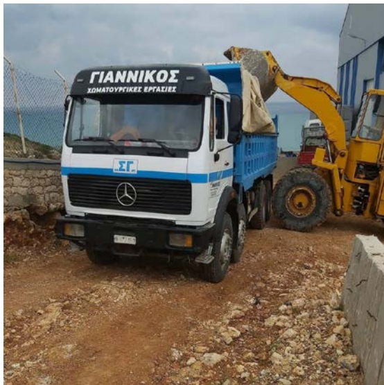
Εικόνα 235 Εκσκαφή μεταλλικής κατασκευής
