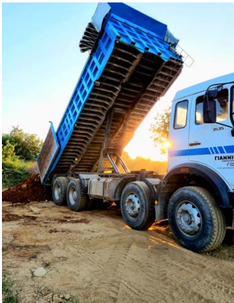
Εικόνα 207 Επιχωμάτωση και διαμόρφωση εξωτερικού χώρου
