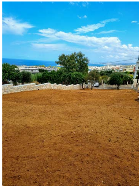
Εικόνα 208 Επιχωμάτωση και διαμόρφωση εξωτερικού χώρου
