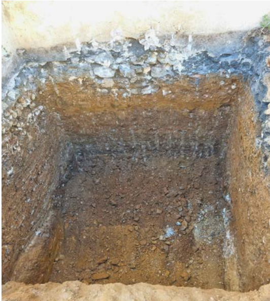
Εικόνα 197 Εκσκαφή θεμελίωσης και ντουλαπιών
