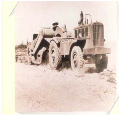
Εικόνα 30 Το πρώτο scraper με κινητήρα
