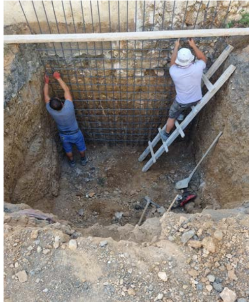
Εικόνα 198 Εκσκαφή θεμελίωσης και ντουλαπιών
