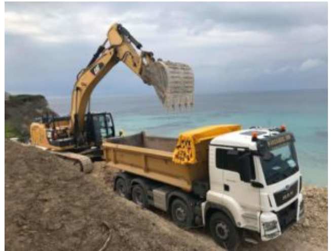
Εικόνα 64 Φόρτωση φορτηγού από εκσκαφέα
