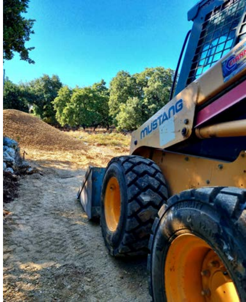
Εικόνα 212 Στρώσιμο δρόμου με υπόβαση 3Αβ
