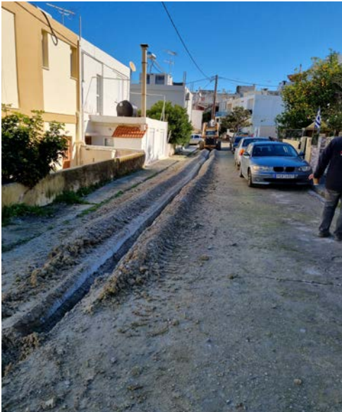
Εικόνα 189 Εξσκαφή μικρής τάφρου
