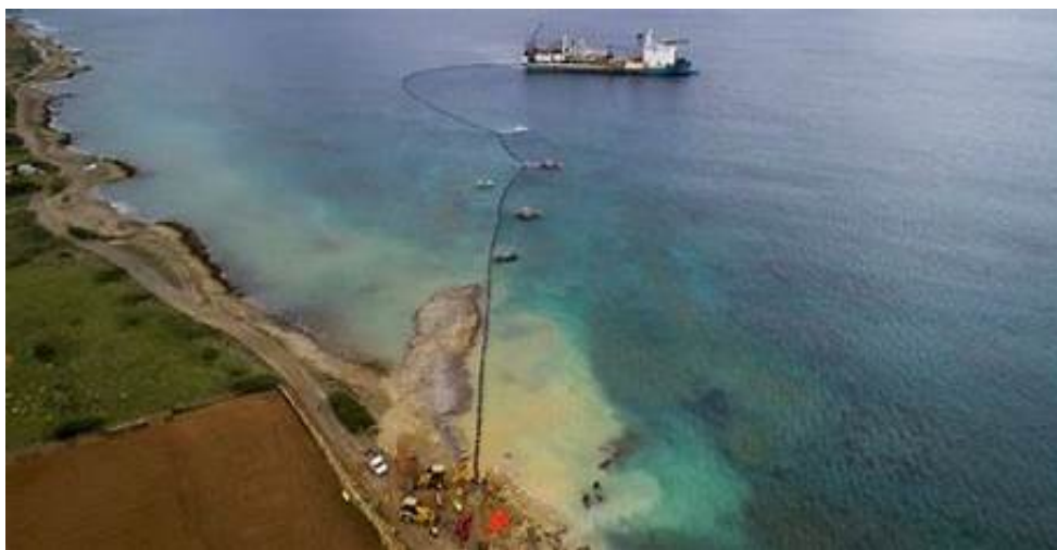
Εικόνα 59 Ηλεκτρική διασύνδεση των Κυκλάδων με την Ήπειρο
