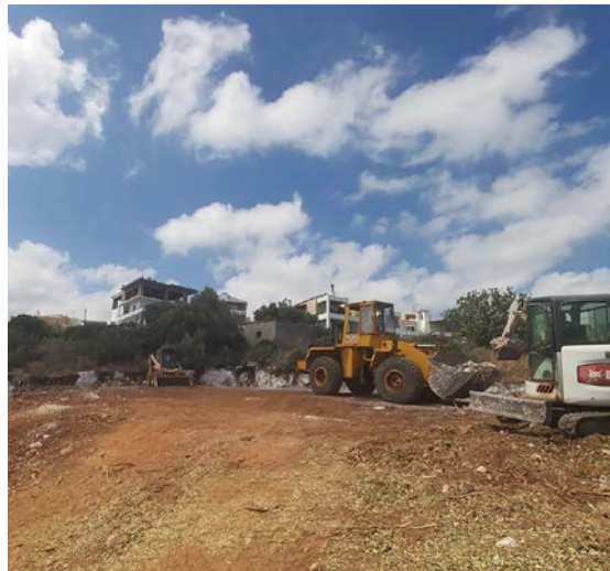
Εικόνα 244 Εκσκαφή με ανισόπεδα επίπεδα
