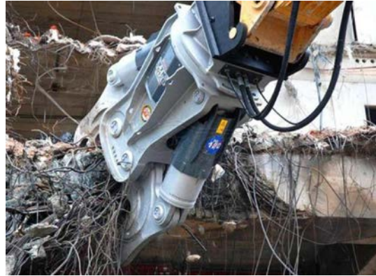
Εικόνα 85 Υδραυλικά ψαλίδια
