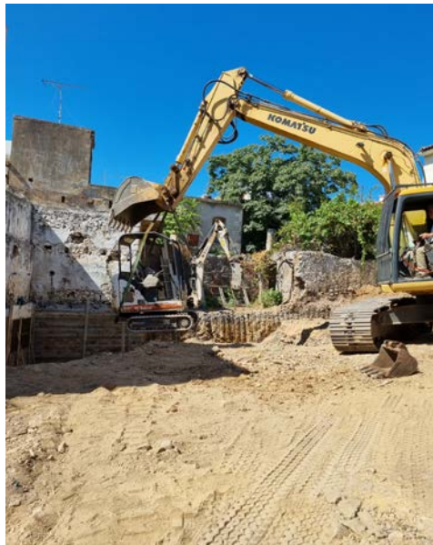
Εικόνα 194 Εκσκαφή θεμελίωσης και ντουλαπιών
