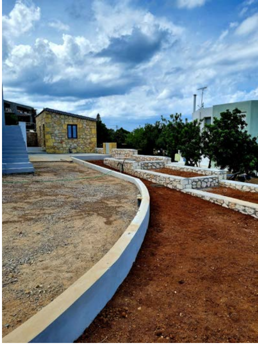
Εικόνα 209 Επιχωμάτωση και διαμόρφωση εξωτερικού χώρου
