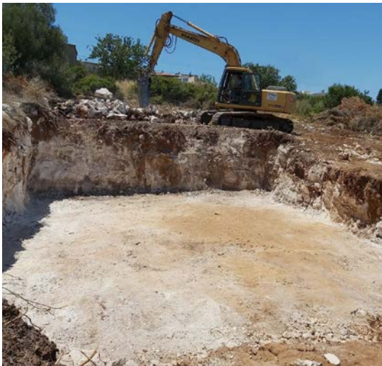
Εικόνα 243 Εκσκαφή με ανισόπεδα επίπεδα
