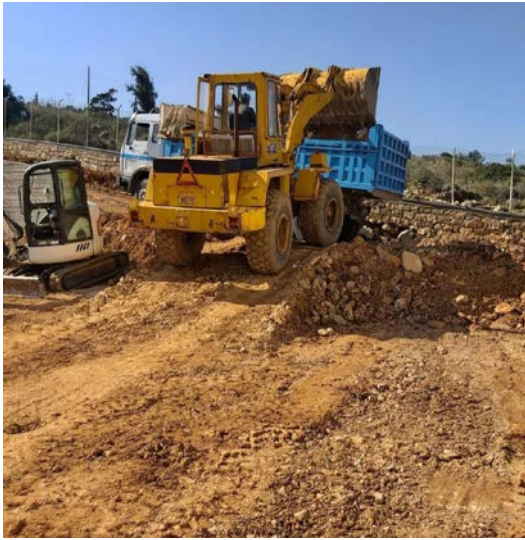
Εικόνα 237 Εκσκαφή μεταλλικής κατασκευής
