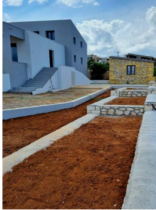
Εικόνα 210 Επιχωμάτωση και διαμόρφωση εξωτερικού χώρου
