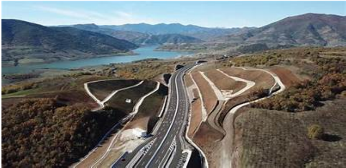
Εικόνα 56 Έναρξη οδικού τμήματος Μπράλος-Άμφισσα
