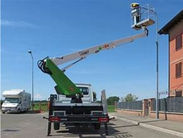
Εικόνα 176 Γερανός για επιδιόρθωση στύλου
