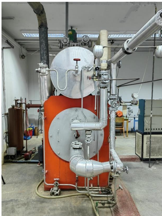
Εικόνα 83: Εγκατάσταση 1 – Ατμολέβητας και ατμοϋδροθάλαμος
