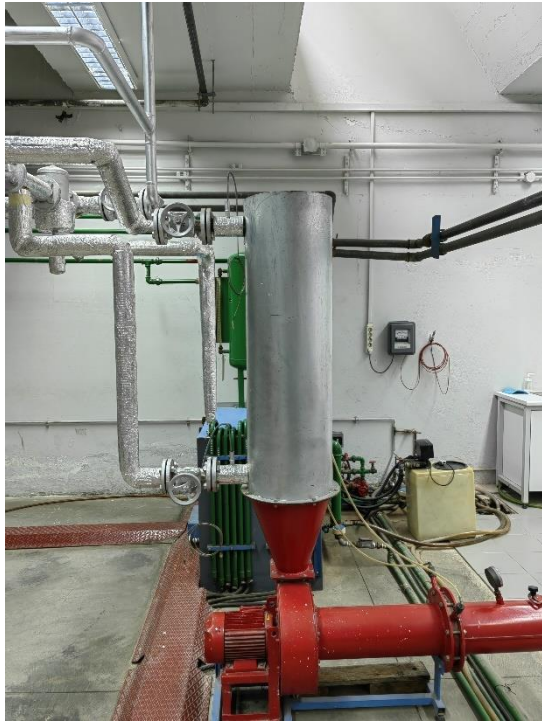
Εικόνα 82: Εγκατάσταση 3α - Αφυπερθερμαντήρας
