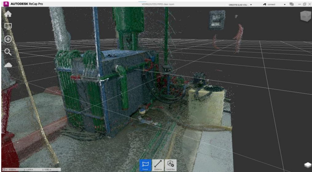
Εικόνα 130: Ιοντοαλλάκτης, σωληνώσεις και καλωδιώσεις.
