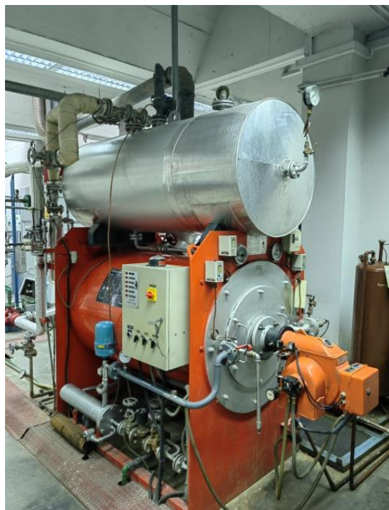
Εικόνα 83: Εγκατάσταση 1 – Ατμολέβητας και ατμοϋδροθάλαμος
