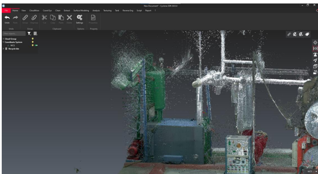
Εικόνα 90: Ακαθάριστο νέφος σημείων της Εγκατάστασης 3 (αριστερή όψη).
