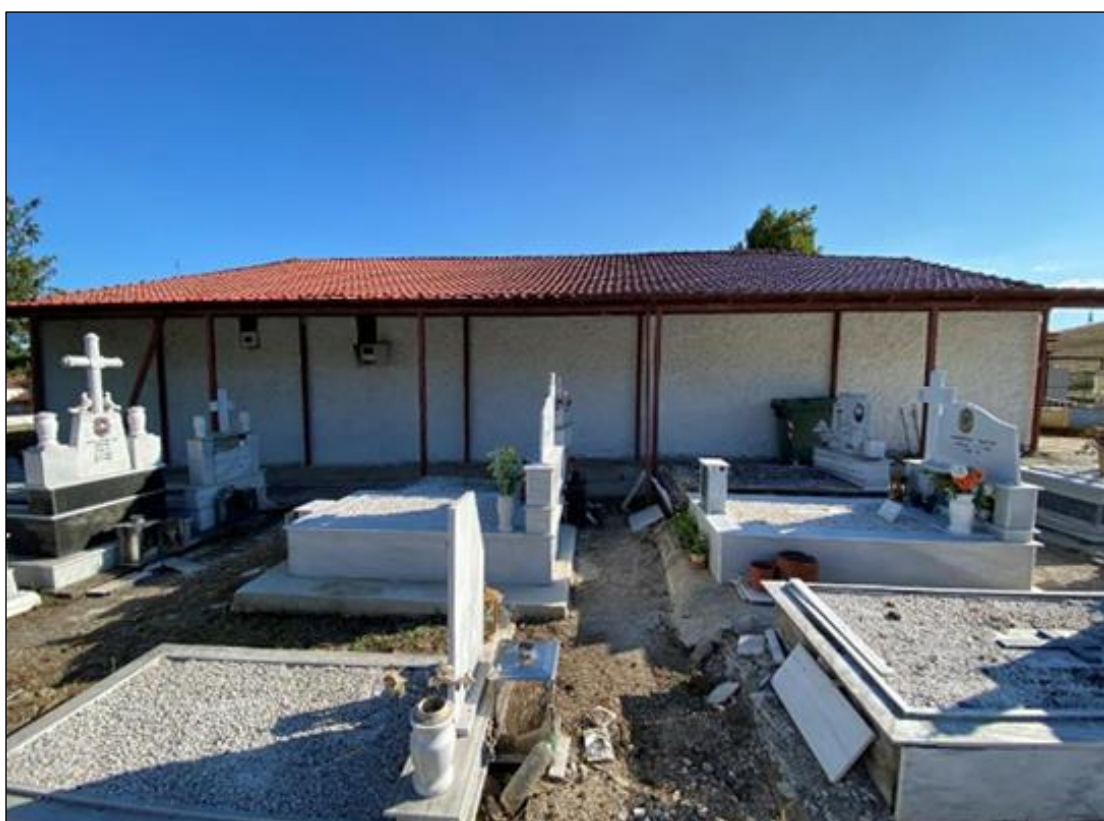
Εικ. 21: Βόρεια όψη του ναού.
