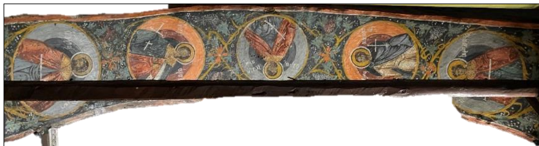
Εικ. 172: Δεύτερο εσωράχιο βόρειας τοξοστοιχίας.
