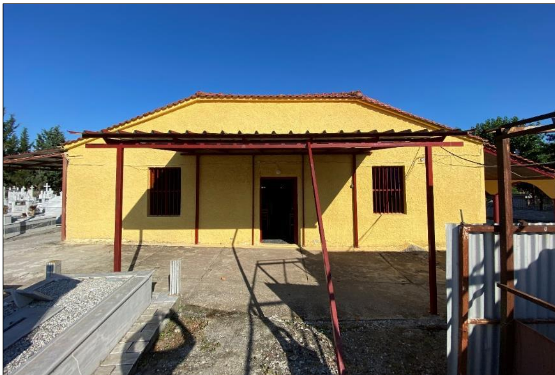
Εικ. 20: Δυτική όψη του ναού.
