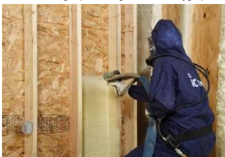
Εικόνα 48: Εγκατάσταση συστήματος μόνωσης Icynene
