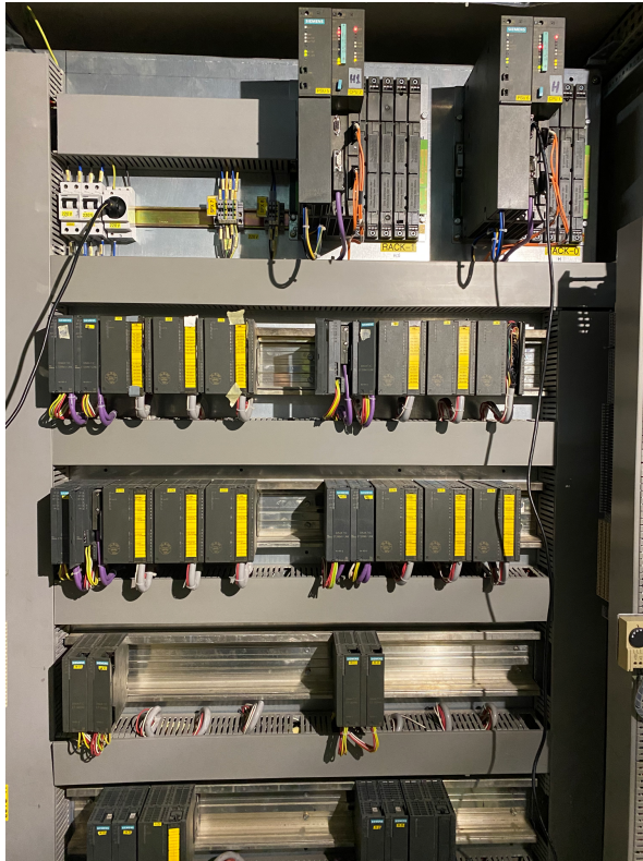
Εικόνα 26. Σύστημα Redundant PLC
