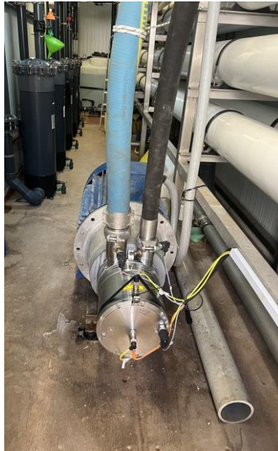
Εικόνα 11: Αντλία υψηλής πίεσης [37].
