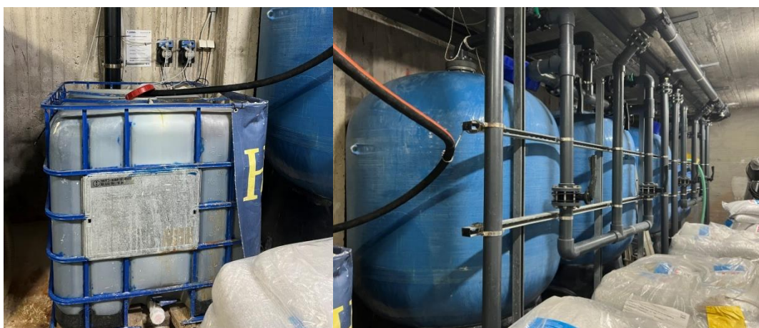
Εικόνα 15: Απεικόνιση σταθμού δοσομέτρησης θεικού οξέος(αριστερά) και των φίλτρων πρόσδοσης σκληρότητας (δεξιά) [37].
