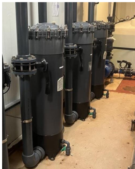
Εικόνα 10: Απεικόνιση τριών φίλτρων φυσιγγίων 5μm [37].
