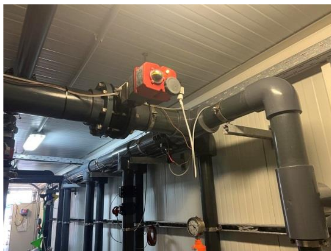
Εικόνα 8: Απεικόνιση αυτόματης βάννας εισόδου [37].
