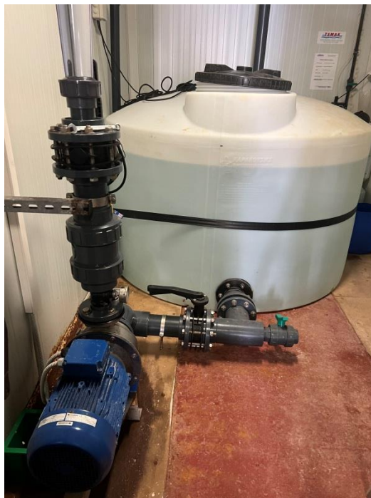
Εικόνα 14: Σύστημα έκπλυσης μεμβρανών [37].
