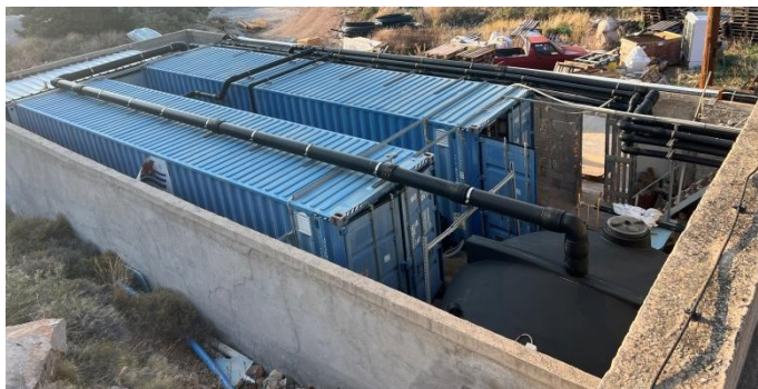
Εικόνα 7: Απεικόνιση των container, μέσα στα οποία βρίσκονται τα συστήματα αντίστροφης ώσμωσης [37].
