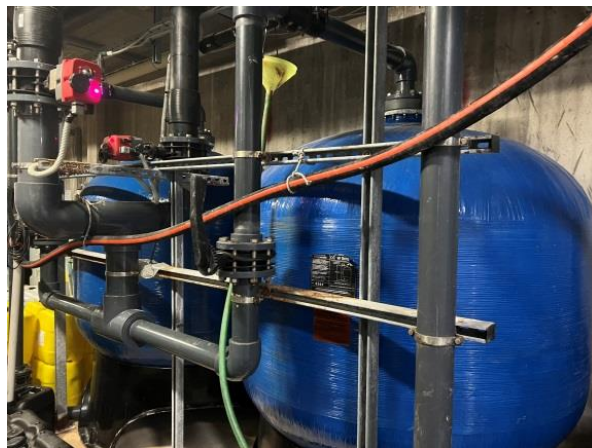
Εικόνα 6: Απεικόνιση αντλιών τροφοδοσίας και φίλτρων άμμου [37].
