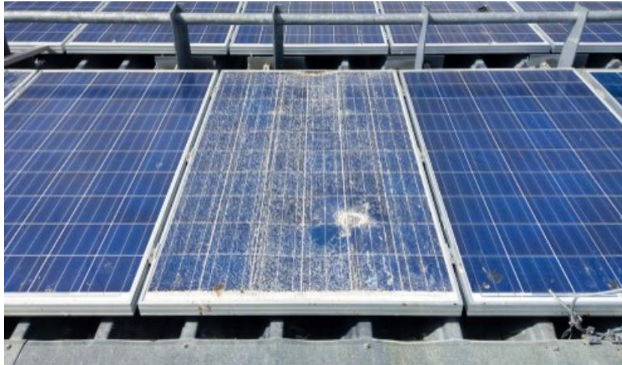
Εικόνα 5.9: Στάδιο παροπλισμού φωτοβολταϊκών πινάκων [37]
