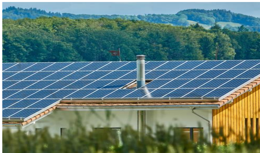
Εικόνα 5.8: Στάδιο χρήσης φωτοβολταϊκών πινάκων [14]
