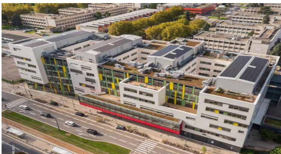
Εικόνα 3.2: Αυτόνομος σταθμός παραγωγής ηλεκτρικής ενέργειας με φωτοβολταϊκά στέγης [26]
