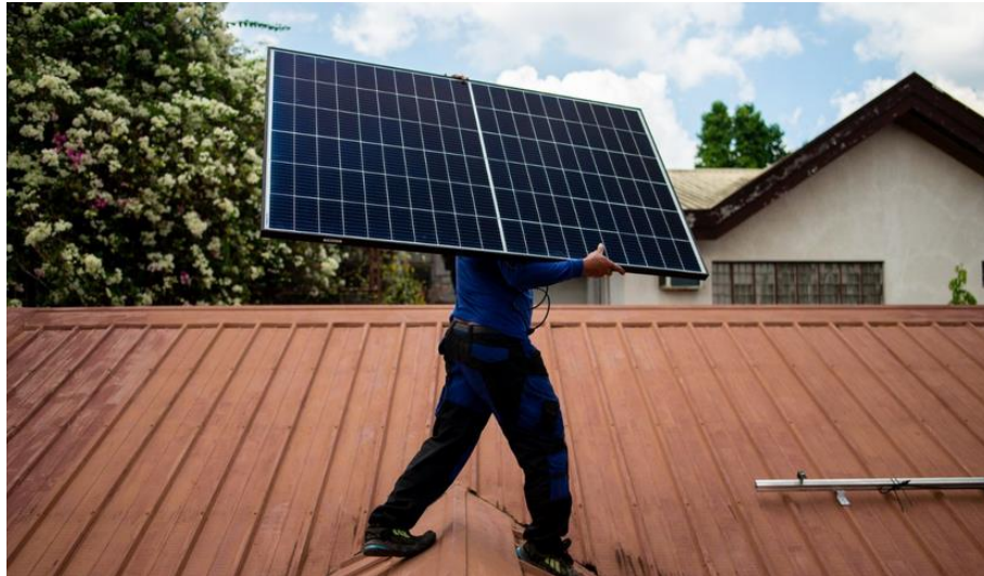
Εικόνα 5.7: Στάδιο εγκατάστασης φωτοβολταϊκών πινάκων [36]
