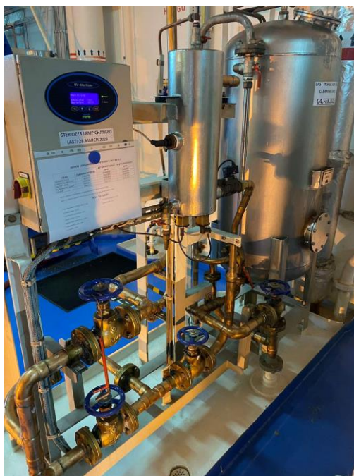
Εικόνα 2.5 : Treatment με υπεριώδη ακτινοβολία , UV Sterilizer ( Πηγή: M/V OWL 1 – TUZZLA, TURKEY – 31/05/2023)
