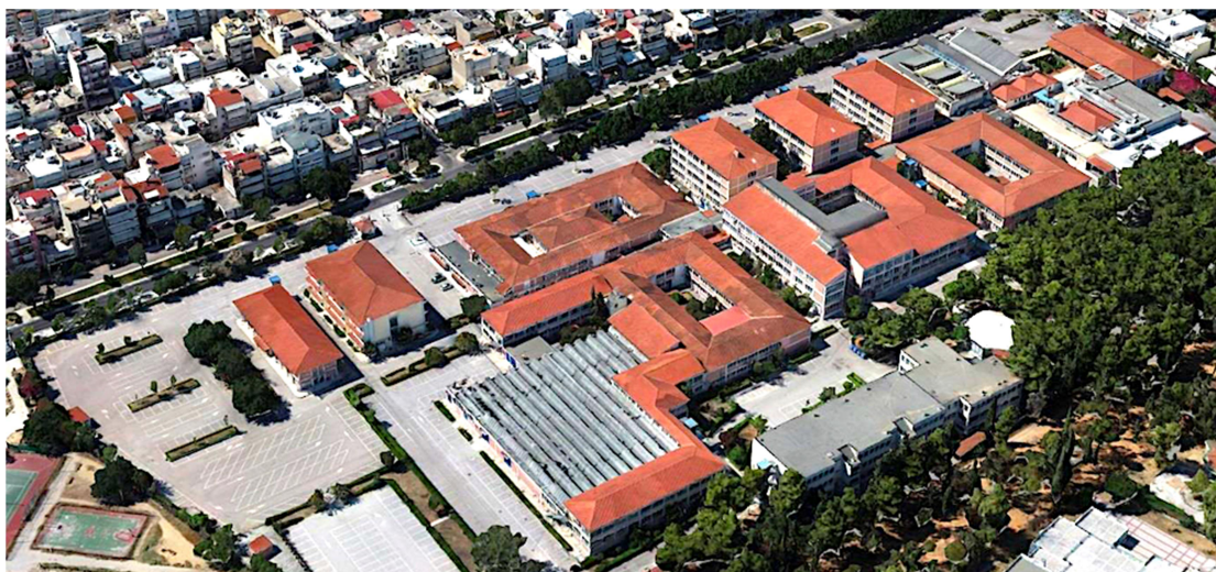
Εικόνα 5: Εφαρμογή της φωτογραμμετρικής μεθόδου γεωμετρικής τεκμηρίωσης των εγκαταστάσεων εξωτερικά και του ευρύτερου χώρου της Πανεπιστημιούπολης άλσους Αιγάλεω του ΠΑ.Δ.Α. με drone (Ερευνητικό Εργαστήριο Γεωχωρικής Τεχνολογίας ΓΑΙΑ)
