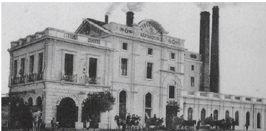
Εικόνα 38: Το πρώτο ατμοκίνητο εργοστάσιο της Ζυθοποιίας Φιξ, στη λεωφόρο Συγγρού https://www.epixeiro.gr/article/89372
