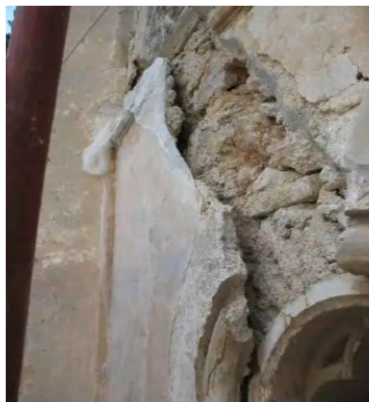
[Εικόνα 9: Επικόλληση προστατευτικού υφάσματος, Πηγή: www.pyrgosvasilissis.gr ]
