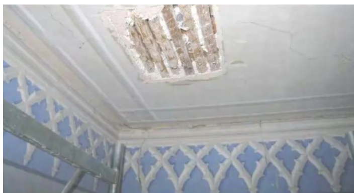
[Εικόνα 4: Τομή για τον έλεγχο κατάστασης διατήρησης των μπαγδαντί και των πατόξυλων Πηγή: www.pyrgosvasilissis.gr ]
