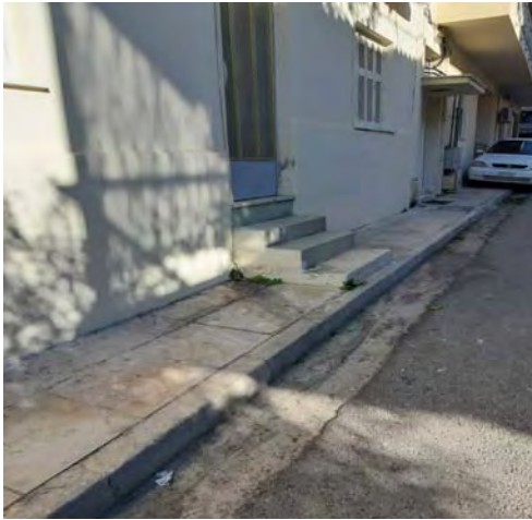
[Εικόνα 47 , Συχνό φαινόμενο των σκαλοπατιών που δεν επιτρέπουν την διέλευση των πεζών από το πεζοδρόμιο , Πηγή: Προσωπικό αρχείο]
