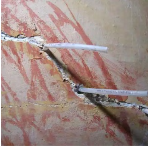
[Εικόνα 6: Στερέωση του υποστρώματος του ζωγραφικού στρώματος των κατακόρυφων τοίχων με ένεμα υδραυλικής κονιάς, Πηγή: www.pyrgosvasilissis.gr ]
