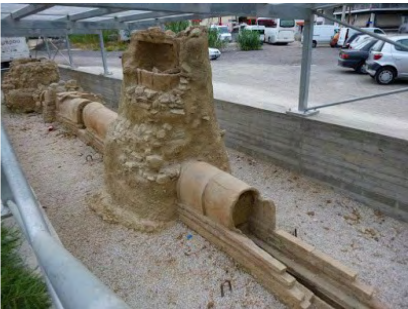
[Εικόνα 12: Πλάγια όψη πήλινος αγωγού ύδρευσης ρωμαϊκών χρόνων, Πηγή: pribas.blogspot.com 2017]
