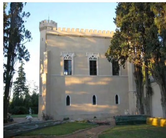
[Εικόνα 11: Η βόρεια πλευρά του Πύργου μετά τις εργασίες αποκατάστασης, Πηγή: www.pyrgosvasilissis.gr ]
