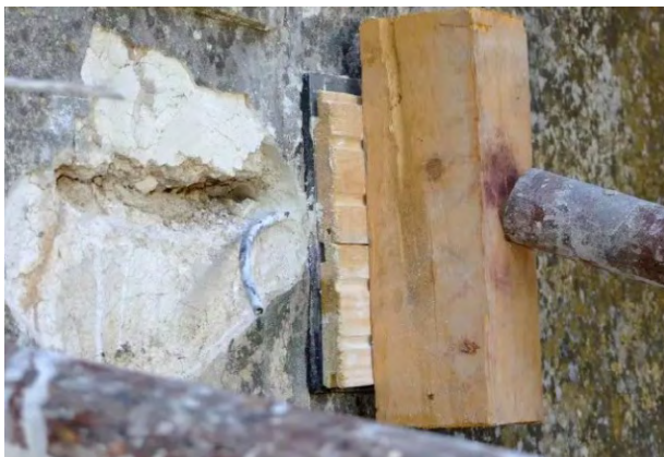
[Εικόνα 10: Άσκηση πίεσης με υδραυλική πρέσα, Πηγή: www.pyrgosvasilissis.gr ]
