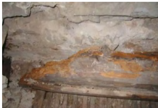
[Εικόνα 5: Λεπτομέρεια του ξύλινου φορέα της οροφής το WC πριν τις εργασίες συντήρησης. Προσβολή από ξυλοφάγα έντομα και σηπτικούς μύκητες , Πηγή: www.pyrgosvasilissis.gr ]
