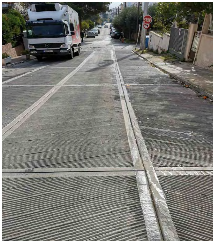
[Εικόνα 62: Δημιουργία τέτοιου οδοστρώματος όπου υπάρχουν ανηφόρες ώστε να μην γλιστρούν τα αυτοκίνητα τις βροχερές ημέρες , Πηγή: Προσωπικό αρχείο]
