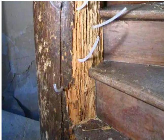
[Εικόνα 8: Στερέωση του ξύλινου φορέα με ένεμα εποξειδικής Ρητίνης, Πηγή: www.pyrgosvasilissis.gr ]
