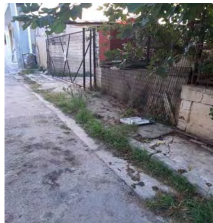
[Εικόνα 50 , Πεζοδρόμιο σε κακή κατάσταση Πηγή: Προσωπικό αρχείο]
