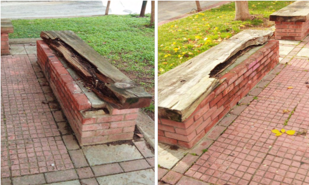
[Εικόνα 26 , Πηγή: Ασυμβίβαστο Ίλιον]
