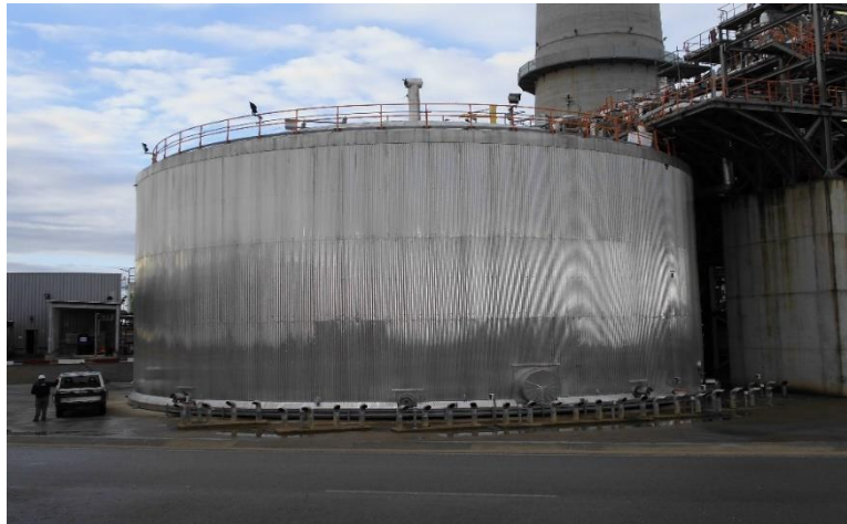
Εικόνα 3.6 : Δεξαμενή αποθήκευσης τηγμένων αλάτων του ηλιοθερμικού σταθμού Gemasolar [82]
