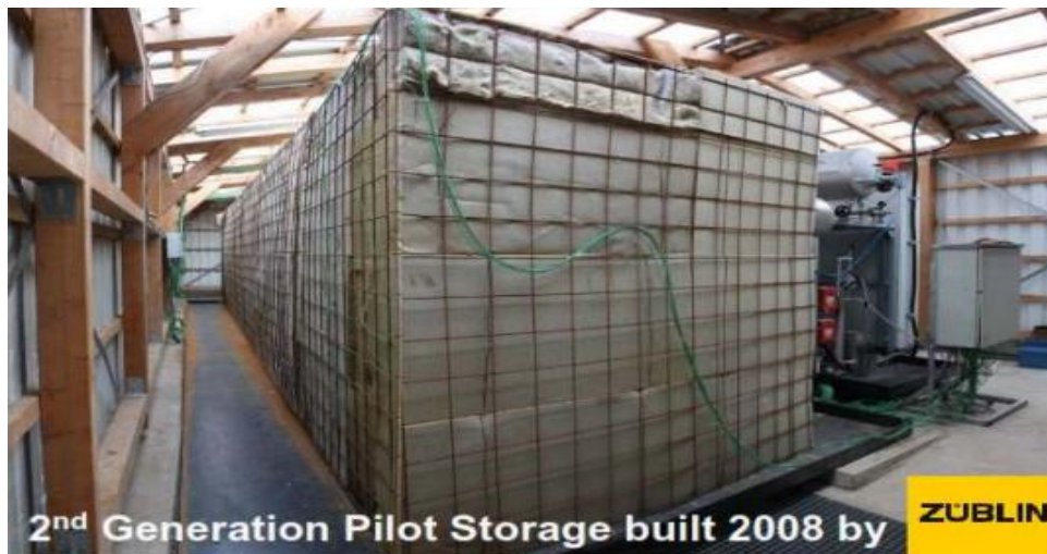
Εικόνα 3.8 : Έμμεση αποθήκευση με σκυρόδεμα [73]
