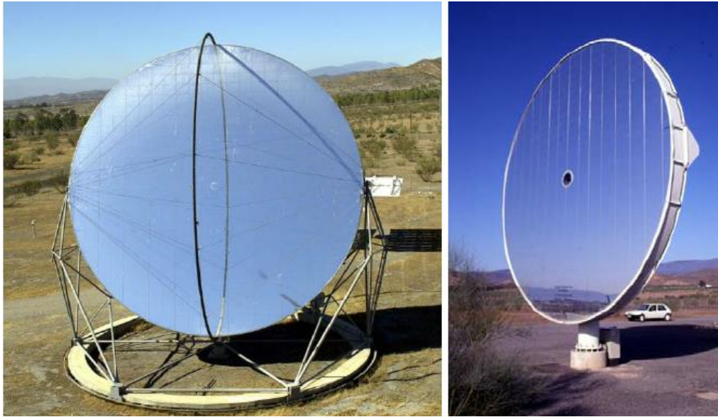
Εικόνα 3.3 : Μεταλλικές μεμβράνες ηλιοστατών με 150 \text{ m}^2 (αριστερή εικόνα) και 44 \text{ m}^2 (δεξιά εικόνα) ανακλαστική επιφάνεια [95]
