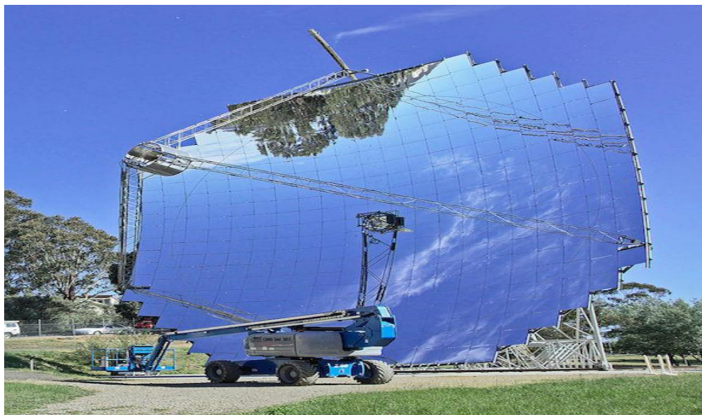
Εικόνα 2.4 : Ένα τεράστιο παραβολικό πιάτο με σκοπό την συγκέντρωση ηλιακής ενέργειας και κάτω από τον δίσκο βρίσκεται ένας γερανός συντήρησης [59]
