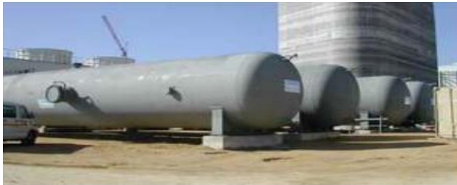
Εικόνα 3.7 : Δεξαμενές αποθήκευσης ατμού του ηλιακού πύργου PS10 στην Ισπανία [79]
