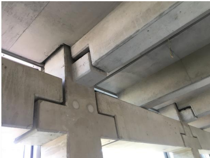
Εικόνα 9: Λεπτομέρεια σύνδεσης των δομικών στοιχείων της οικοδομής © FAR frohn&rojas ("Wohnregal, Berlin - Deutsche BauZeitschrift," 2020)
