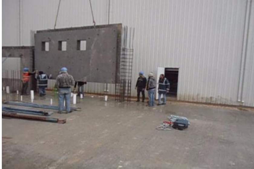
Εικόνα 4: Τοποθέτηση εξωτερικών τοίχων με οδηγούς τις αναμονές των υποστυλωμάτων (“Κτήρια Concretan - Beton,” 2024)
