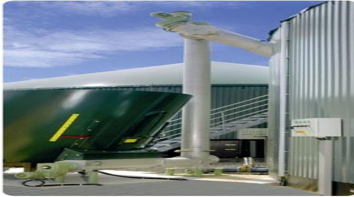
Εικόνα 3.4.5.2:Τροφοδότηση πρώτης ύλης με κοχλία[7].
