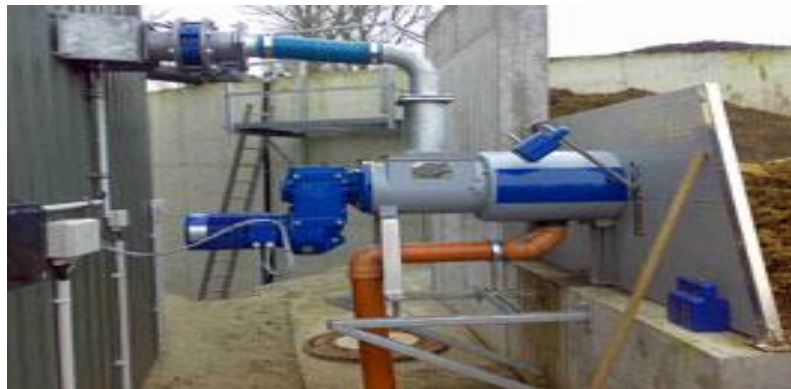
Εικόνα 3.4.5.6: Σύστημα αποθήκευσης υπολείματος[7].
