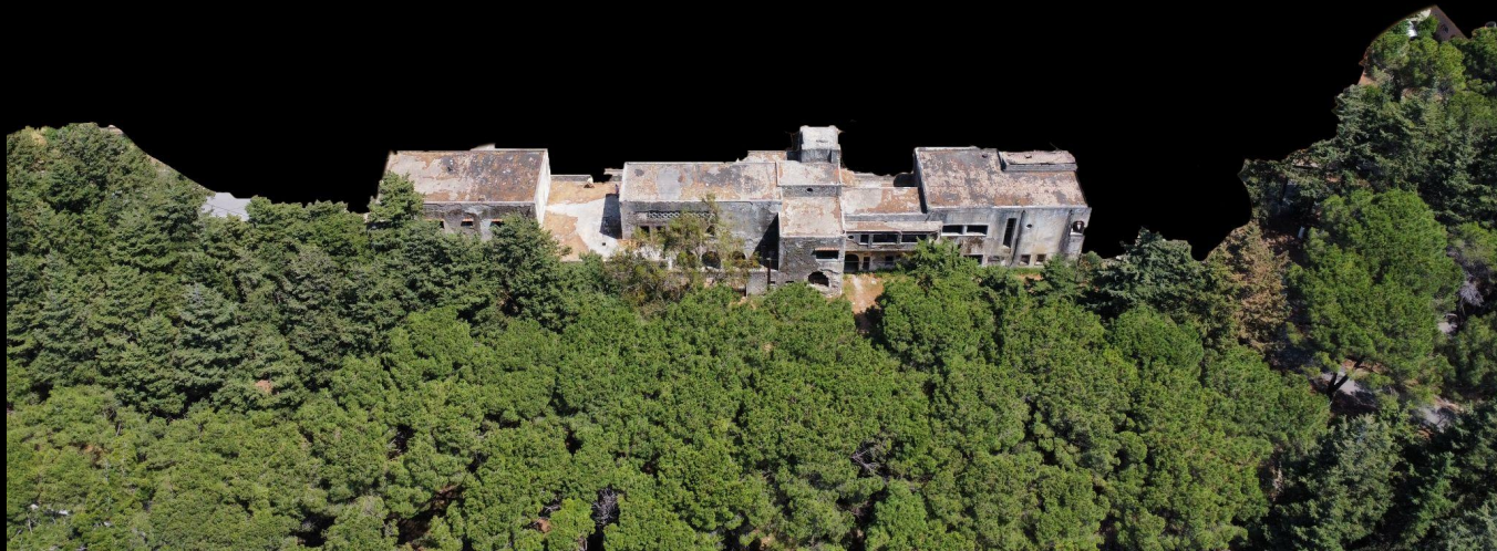
Απομόνωση των γειτονικών κτισμάτων
