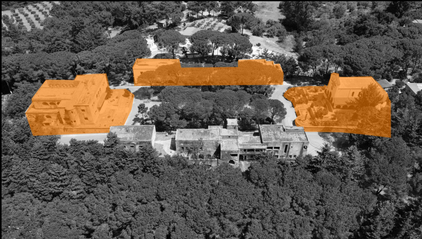
Φωτογραφία από drone - Γειτονικά Κτίρια
