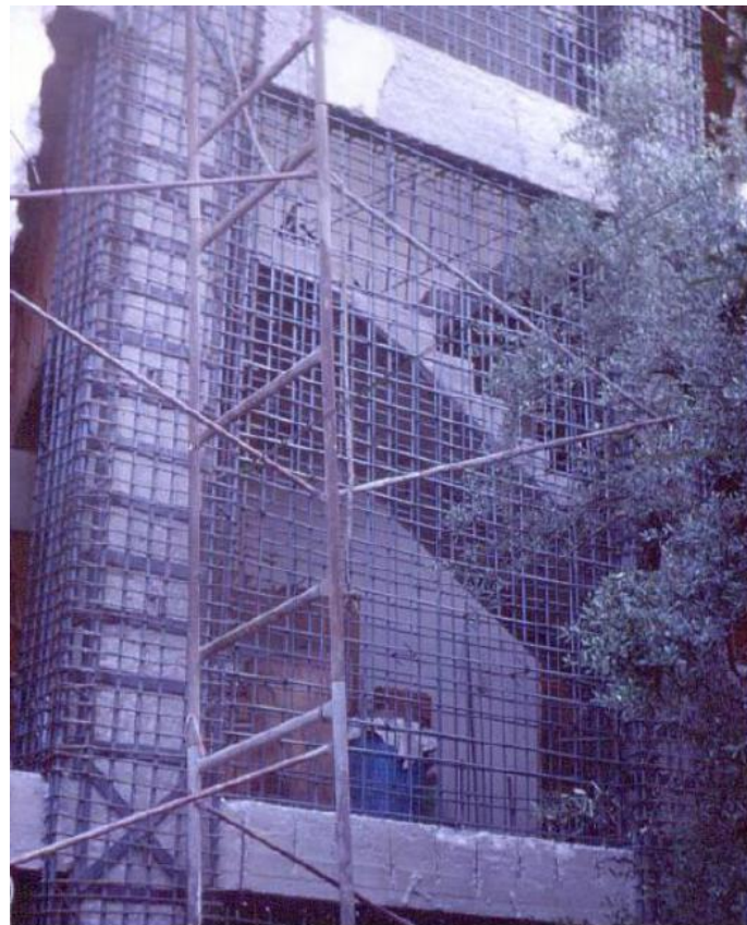
Σχήμα 4.8: Προσθήκη τοιχώματος και ενίσχυση υποστύλωματος (Δρίτσος, 2005)
