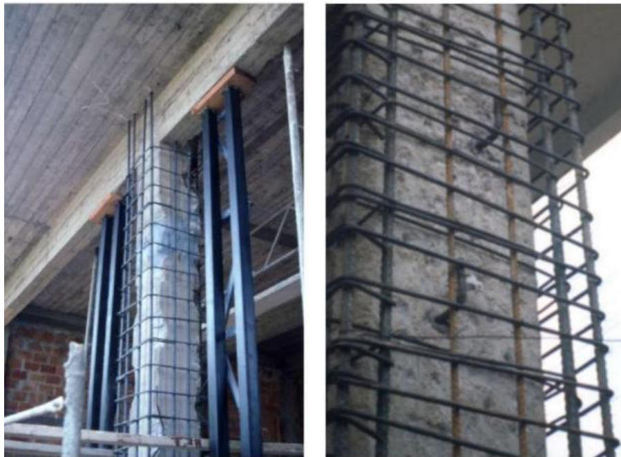
Σχήμα 4.4: Ενίσχυση υποστυλώματος με μανδύες ΟΣ.( http://episkeves2.civil.upatras.gr/ )
