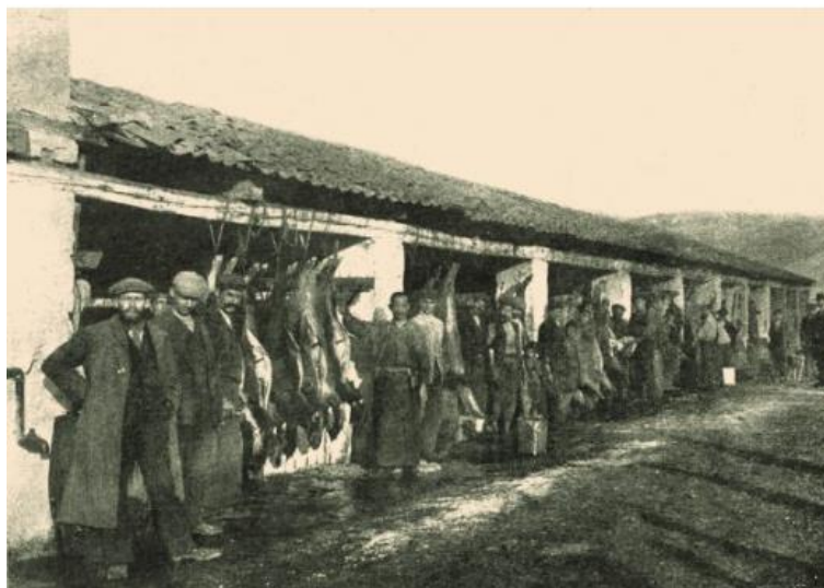
Εικόνα 2.10: Εργασίες στα Δημοτικά σφαγεία (Τσαμπάζη Β., 2021)
