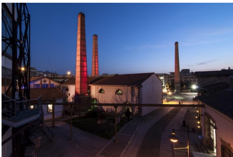
Εικόνα 3.2: Εργοστάσιο Φωταερίου (Αρχαιολογία online, 2015)
