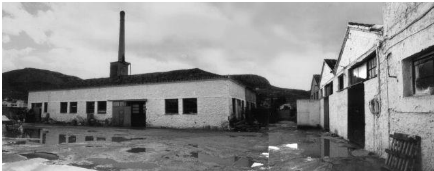
Εικόνα 6.42: Εργοστάσιο κονσερβοποιίας τομάτας «Ανθός» (Το Βήμα, 2017)
