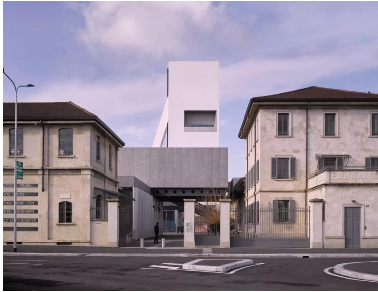
Εικόνα 6.37: Είσοδος συγκροτήματος (OMA Office Work, 2018)
