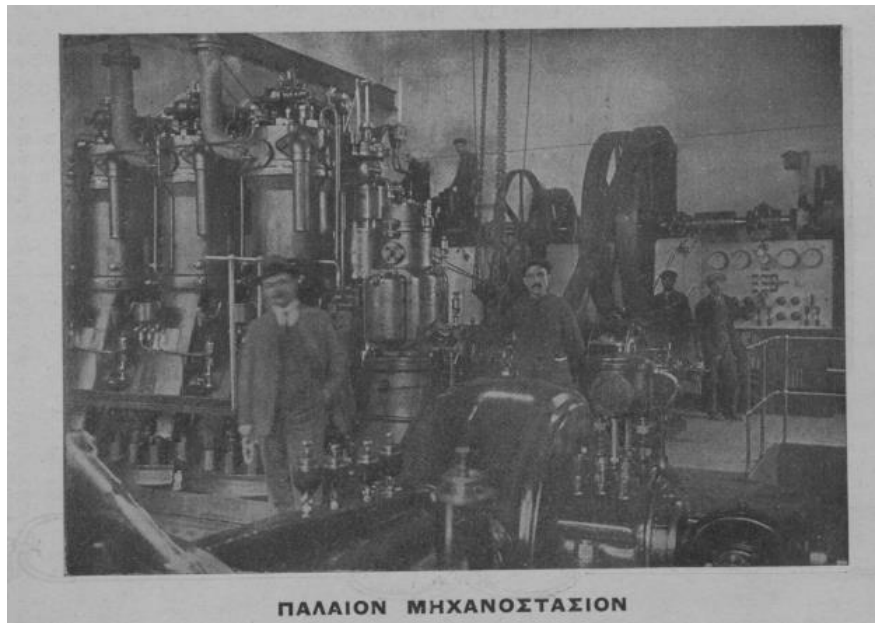
Εικόνα 6.5: Εγκαταστάσεις παλαιού μηχανοστασίου (Χατζηγιάννου Ι.Χ., 1922)
