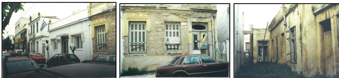
Εικόνες 10-12: Τα κτίρια της οδού Μυιάλης αρ. 66-68 πριν την κατεδάφιση
