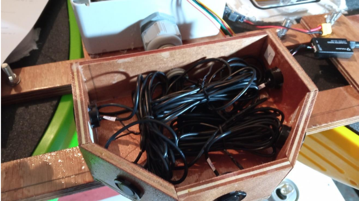
Εικόνα 85 - Τακτοποίηση των καλωδίων στο εσωτερικού του κουτιού
