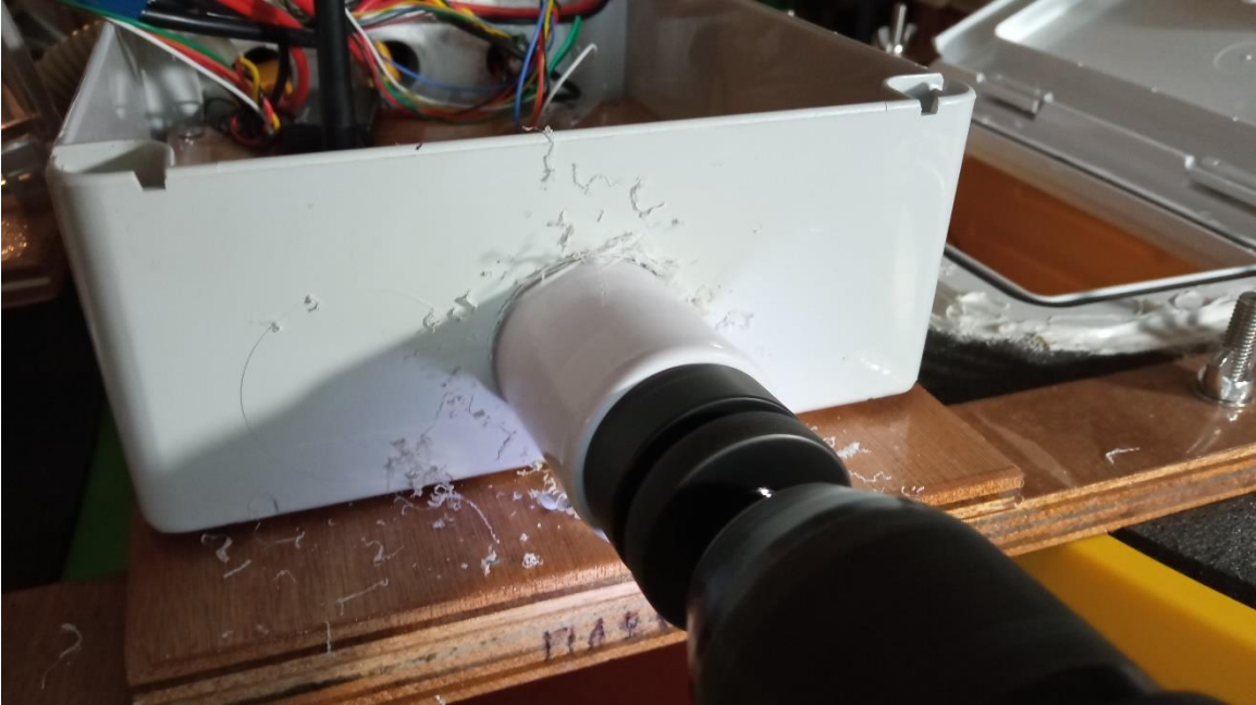
Εικόνα 77 - Διάνοιξη οπής στο στεγανό πλαστικό κουτί
