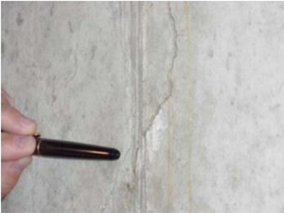
Σχήμα 3.7: Παράδειγμα ρωγμών πλαστικής συρρίκνωσης (McGranahan, Balk, & Anderson, 2007)
