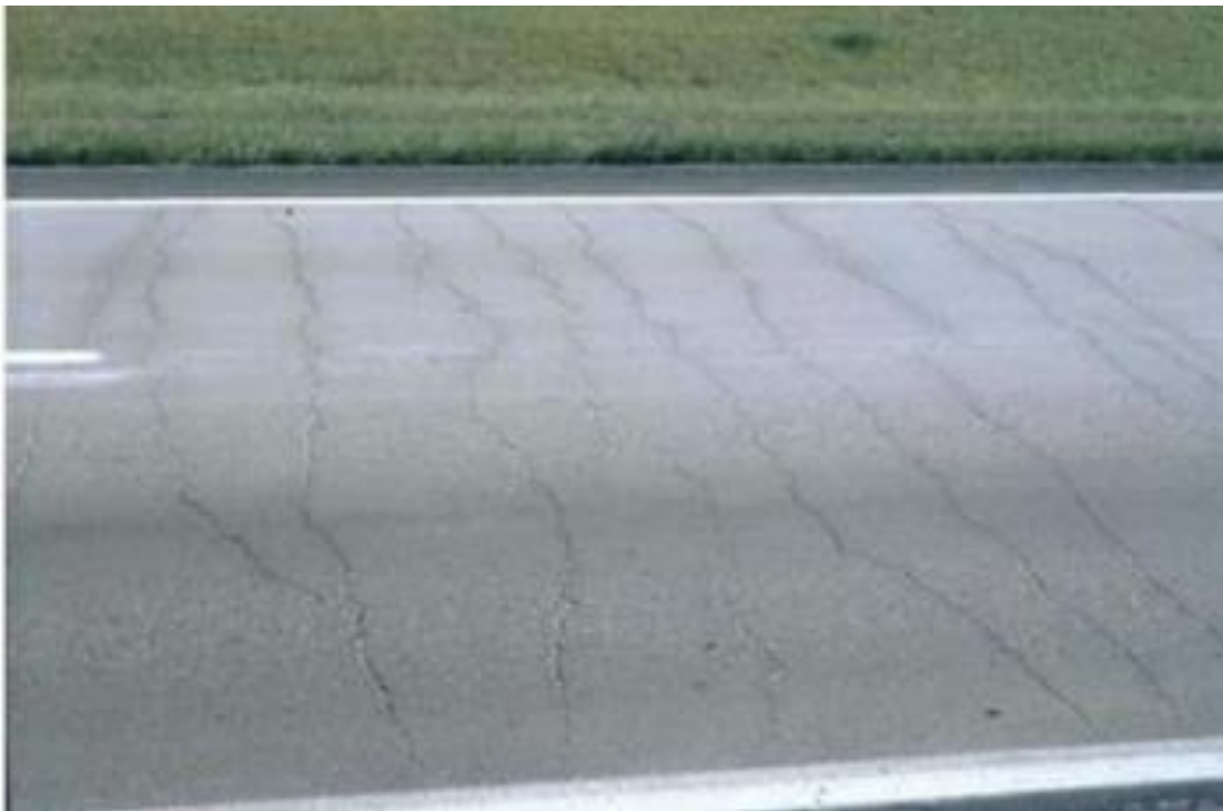
Σχήμα 3.9: Παράδειγμα θερμικής ρηγμάτωσης (Baker et al., 2010)
