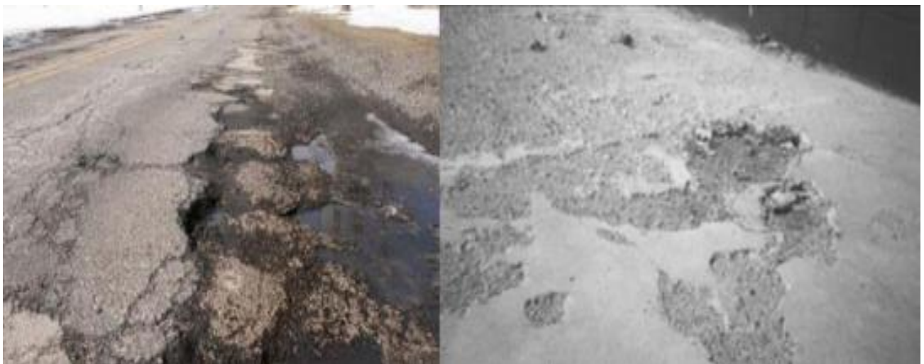
Σχήμα 3.13: Παράδειγμα φθοράς από πήξη – τήξη σε δρόμους και καταστρώματα γεφυρών (Θωίδου & Φουτάκης, 2015; McGranahan et al., 2007)
