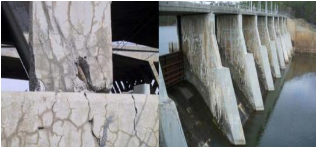
Σχήμα 3.11: Παραδείγματα φθοράς από αλκαλοπυριτική αντίδραση (ASR) (Hamin & Gurrán, 2009)
