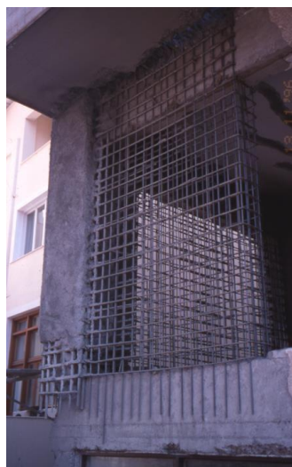
Εικόνα 4.3 Ενίσχυση κτιρίου με προσθήκη πτερυγίου σε σύνδεση με υφιστάμενο υποστύλωμα (ΑΙΦΑΚΑΤ Α.Ε)
