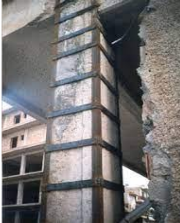
Εικόνες 4.6 Ενίσχυση υποστυλωμάτων με περίσφηση (ΑΛΦΑΚΑΤ Α.Ε)
