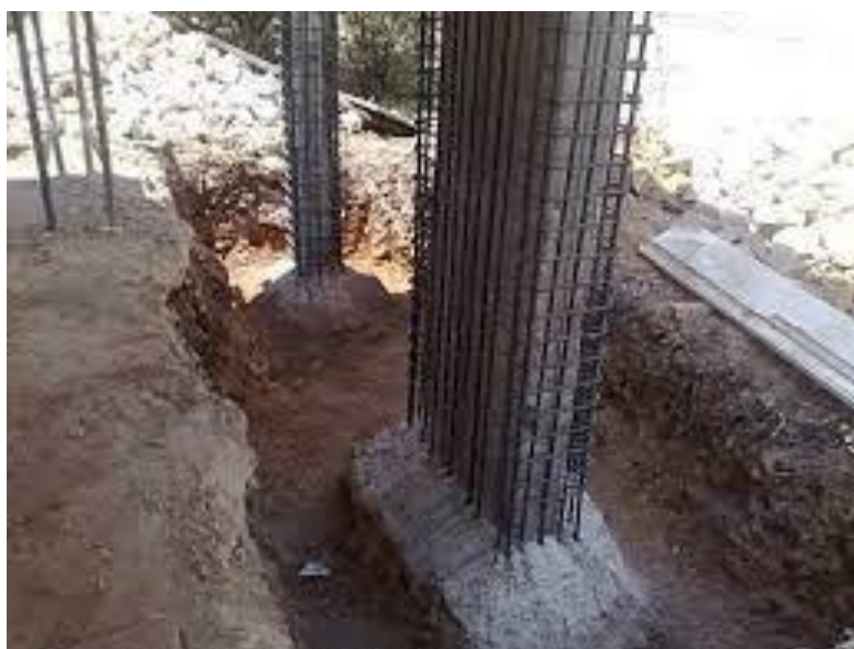
Εικόνες 4.4,4.5 Ενίσχυση υποστυλωμάτων με εκτοξευμένο σκυρόδεμα (ΑΛΦΑΚΑΤ Α.Ε)
