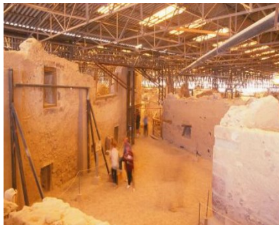
Εικόνα 29 : Ο αρχαιολογικός χώρος του Ακρωτηρίου Σαντορίνης (2001), προ της καταρρεύσεως του βαρύτερου στεγάστρου που αντικατέστησε το εικονιζόμενο. Η αστοχία στη θεμελίωση κάποιων εκ των υποστυλωμάτων, ίσως ευθύνεται για την κατάρρευσή του.
