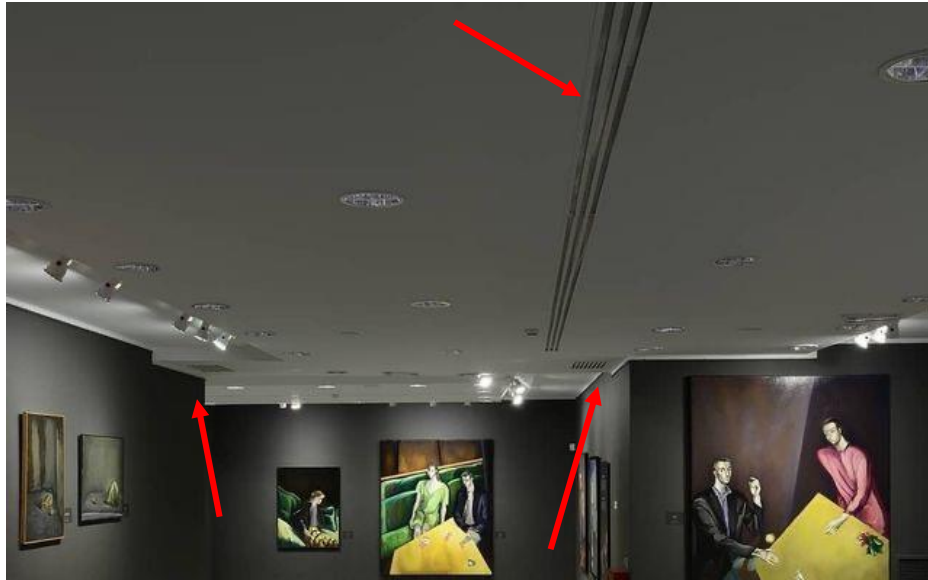
Εικόνα 45. Σύστημα κλιματισμού και εξαερισμού σε αίθουσα του Μουσείου Σύγχρονης Τέχνης του Ιδρύματος Γουλανδρή.
