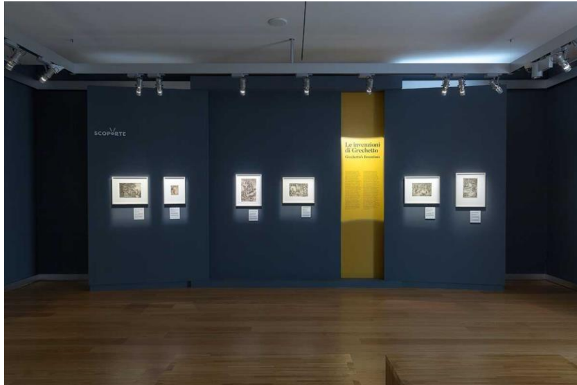
Εικόνα 207. Τεχνητός φωτισμός πινάκων πιθανώς με φωτισμό LED και κρυφός φωτισμός χώρου σε αίθουσα του Palazzo Reale.
