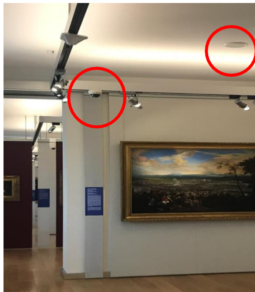
Εικόνα 167. Κάμερα παρακολούθησης και sounder σε αίθουσα του Palazzo Reale.
