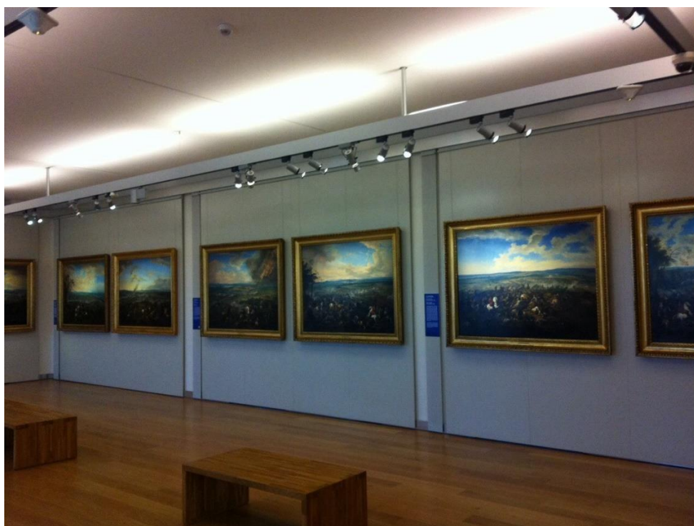
Εικόνα 145. Χρήση γυψοσανίδων στα παράθυρα του μουσείου και συρματόσχοινων για την έκθεση των έργων τέχνης στο Palazzo Reale.
