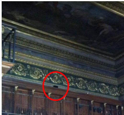
Εικόνα 87. Σύστημα κλιματισμού και εξαερισμού σε αίθουσα του Palazzo Reale.
