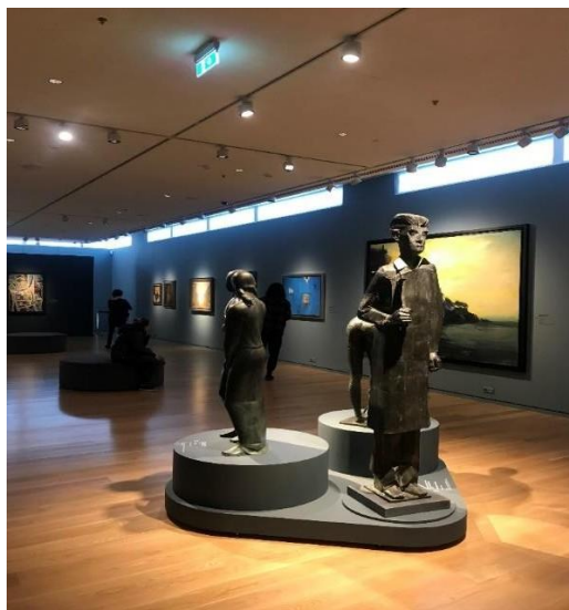
Εικόνα 212. Τεχνητός φωτισμός από την οροφή αίθουσας με την τεχνική big angle , τεχνητός φωτισμός αντικειμένων και πινάκων πιθανώς με φωτισμό LED και την τεχνική small ή middle angle και φυσικός φωτισμός που προκύπτει από φεγγίτες σε αίθουσα του Μουσείου Σύγχρονης Τέχνης του Ιδρύματος Γουλανδρή.
