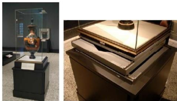
Εικόνα 132. Στήριξη προθήκης με isolator.
