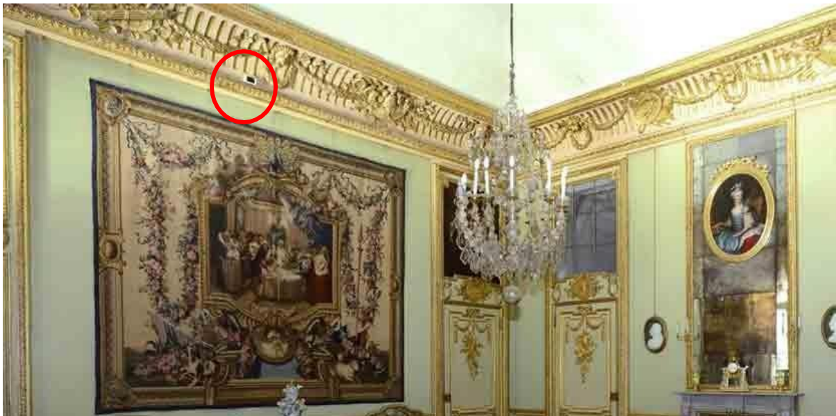
Εικόνα 46. Σύστημα εξαερισμού ή κλιματισμού σε αίθουσα του Palazzo Reale.
