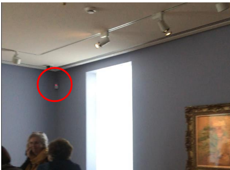
Εικόνα 168. Αισθητήρας κίνησης σε γωνία αίθουσας του Μουσείου Σύγχρονης Τέχνης του Ιδρύματος Γουλανδρή.
