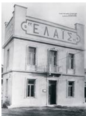
Εικόνα 1.7: Βιομηχανία ΕΛΑΪΣ πηγή: (old-elais.servers.mediacdn.com)
