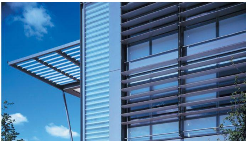
Εικόνα 3.7: Εξωτερικά κινητά σκίαστρα πηγή:4green.gr
