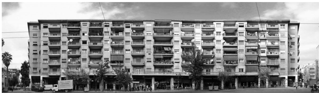
Εικόνα 7.2: Πολυχρηστικό συγκρότημα στο Μεταξουργείο Πηγή: www.sadas-pea.gr
