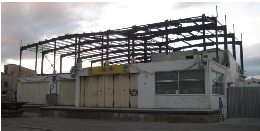
Εικόνα 7.6: Βιομηχανικό κτίριο στο Ρέντη
