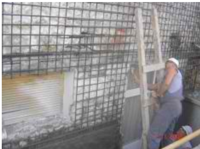
Εικόνα 4.5: Μανδύες επί φερόντων τοίχων και γραμμικών στοιχείων σκυροδέματος.
