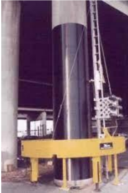
Εικόνα 6.3 & 6.4: Η ειδική μηχανή ρομπότ για την αυτοματοποιημένη περιτύλιξη υποστρωμάτων.
