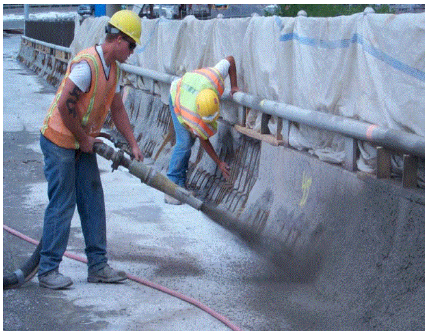
Εικόνα 2.1: Εφαρμογή εκτοξευόμενου σκυροδέματος
