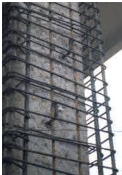
Εικόνα 4.2: Ενίσχυση υποστυλώματος με μανδύα.
