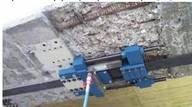
Εικόνα 6.5: Εφαρμογή προέντασης ελάσματος και αγκύρωσης στο άκρο.
