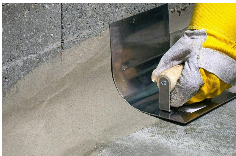
Εικόνα 4.8: Διάστρωση επισκευαστικού κονιαμάτος.
