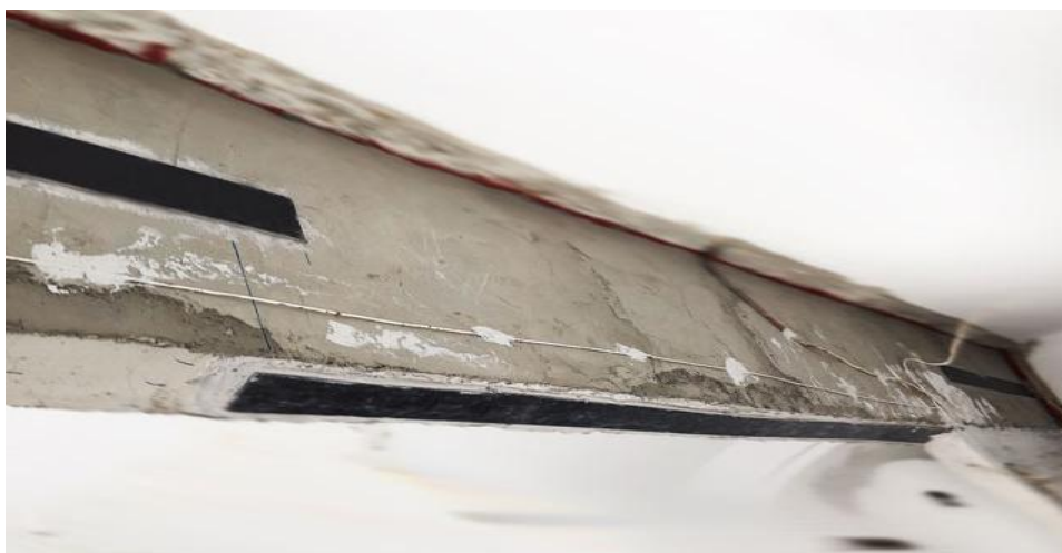
Εικόνα 6.10: Καμπτική ενίσχυση δοκού με ανθρακοελάσματα.
