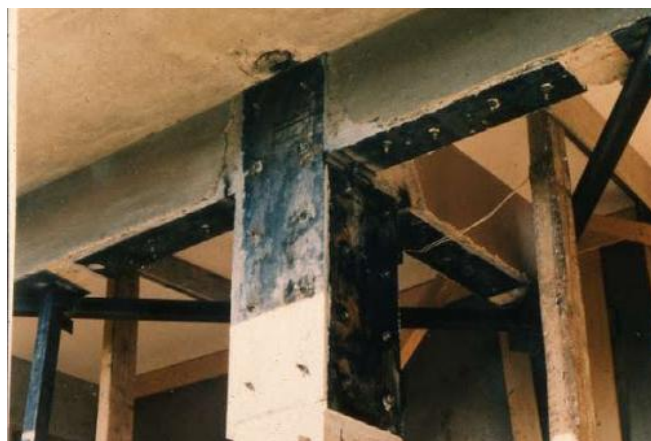
Εικόνα 4.9 & 4.10: Διαδικασία εφαρμογής χαλύβδινων επικολλητών ελασμάτων.
