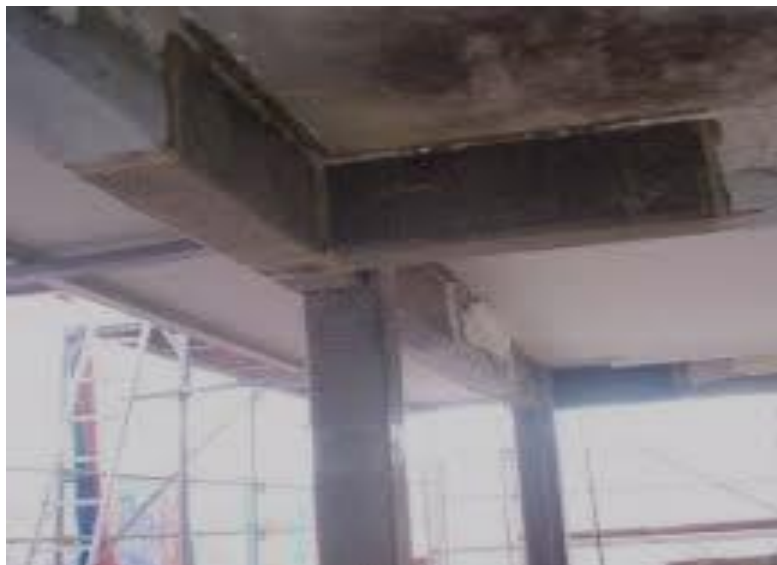
Εικόνα 6.12: Ενισχυμένος κόμβος.
