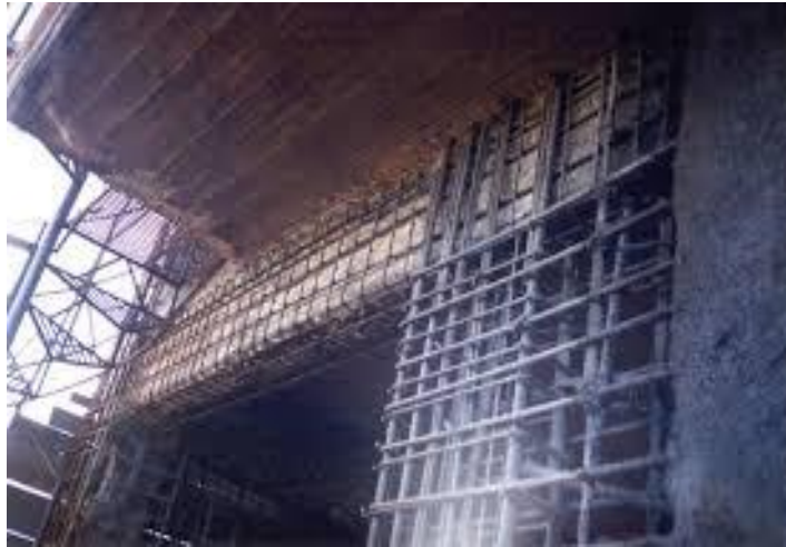
Εικόνα 4.3: Ενίσχυση κόμβου δοκού υποστυλώματος με μανδύα.
