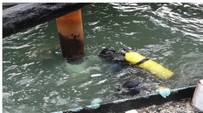
Εικόνα 5.22: Οι δύτες εφαρμόζουν το Syntho-Glass XT για την επιδιόρθωση πολλαπλών ελαττωμάτων σε έναν βυθισμένο αγωγό πετρελαίου άνθρακα 10 ιντσών σε βάθος 28 μ. Υπεράκτιας Μαλαισίας
