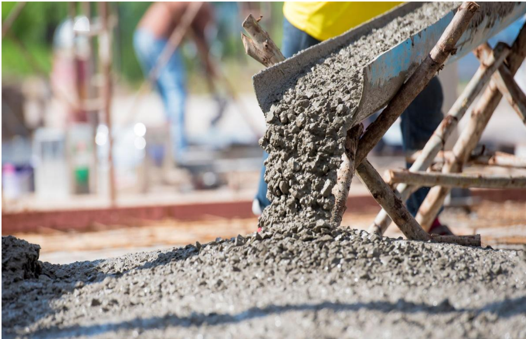
Εικόνα 1.1: Εφαρμογή σκυροδέματος
