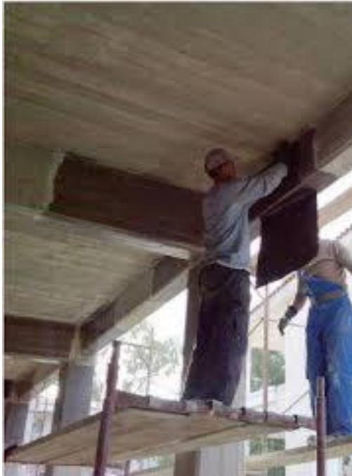
Εικόνα 6.14 και 6.15: Εφαρμογή ανθρακούφασμάτων για την ενίσχυση κόμβου/ Σχήμα ενίσχυσης κόμβου με σύνθετα υλικά.
