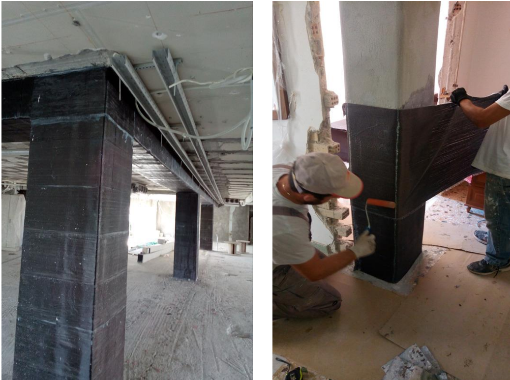
Εικόνα 6.8 & 6.9: Ενισχυμένο υποστώλωμα/ Εφαρμογή υφάσματος για την περίσφιγξη υποστυλώματος.
