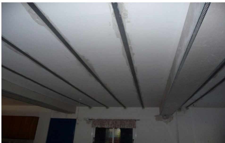
Εικόνα 6.11: Καμπτική ενίσχυση πλάκας με ανθρακοελάσματα.
