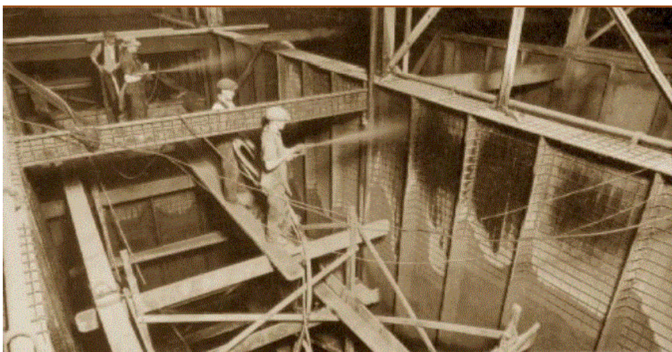
Εικόνα 2.2: Οι πρώτες εφαρμογές εκτοξευόμενου σκυροδέματος.
