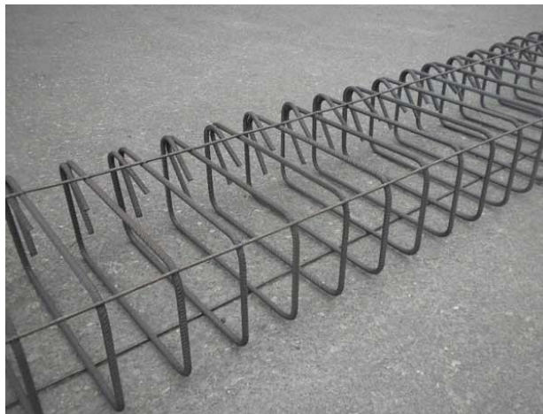
Εικόνα 4.4: Ο κλωβός που δημιουργείται μετά την αναδίπλωση του πλέγματος.
