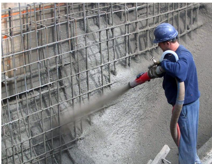
Εικόνα 2.5: Εφαρμογή του εκτοξευόμενου σκυροδέματος με την μέθοδο ξηρής ανάμιξης.
