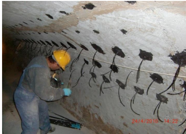
Εικόνα 4.6: Τοποθέτηση βλήτρων.
