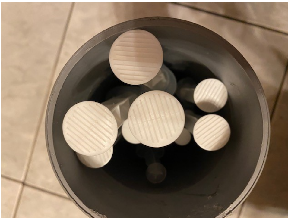
Εικόνα 6.4: Συγκόλληση φελιζόλ στο σωλήνα
