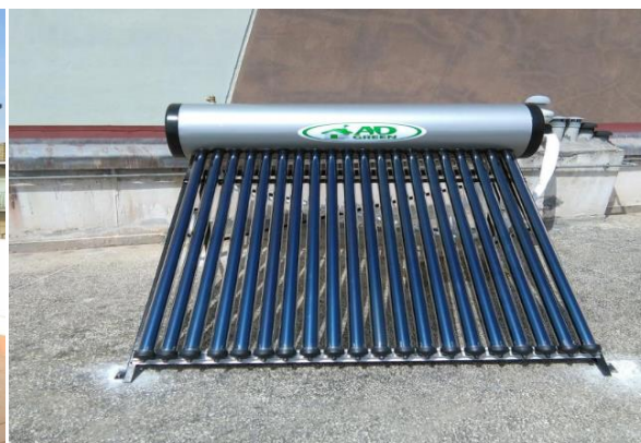
Εικόνα 4.3 Ηλιακός θερμοσίφοντας οικιακής χρήσης με συλλέκτες σωλήνων κενού [Ιστ.11]
