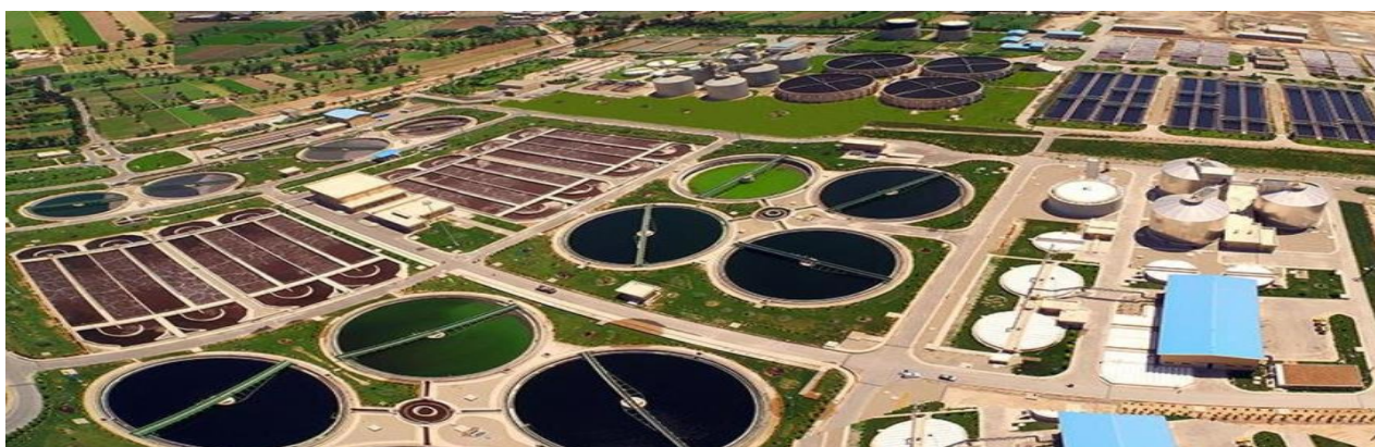
Εικόνα 4.35 Μονάδα επεξεργασίας λυμάτων [Ιστ.44]
