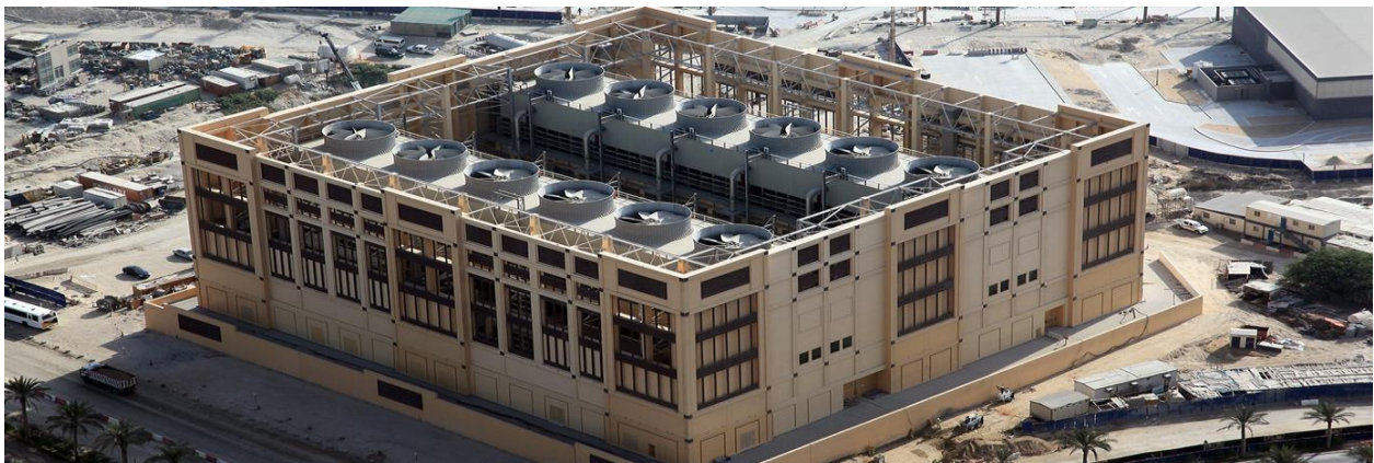
Εικόνα 4.30 Κεντρικός σταθμός τηλεψύξης στο Ντουμπάι [Ιστ.39]
