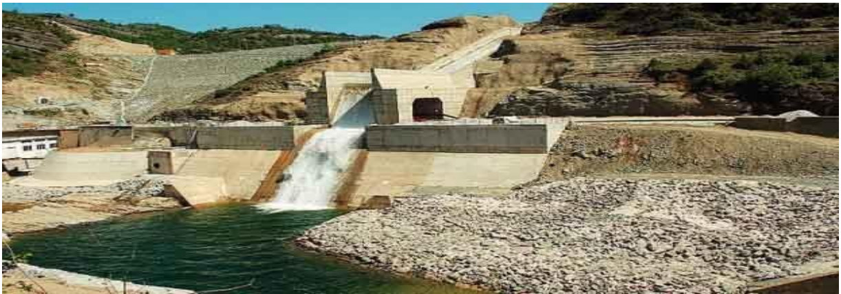
Εικόνα 4.15 Μικρό Υδροηλεκτρικό έργο [Ιστ.24]
