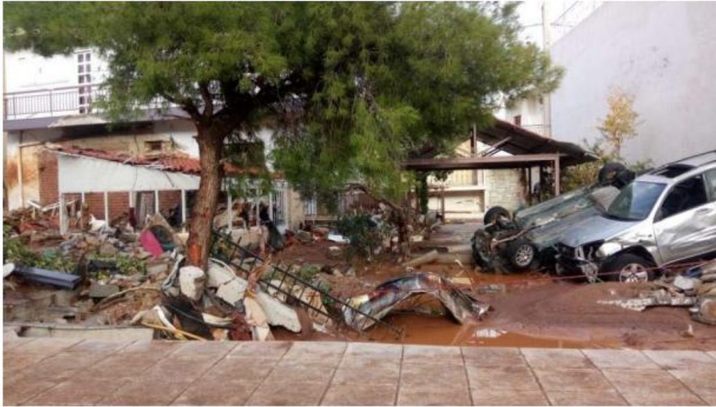
Εικόνα 6: Υλικές ζημιές στην περιοχή της Μάνδρας [1]
