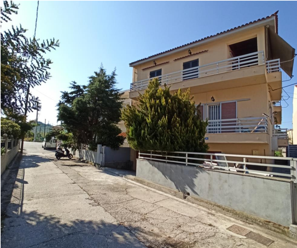
Εικόνα 13. Όμορο κτήριο από δυτικά.
