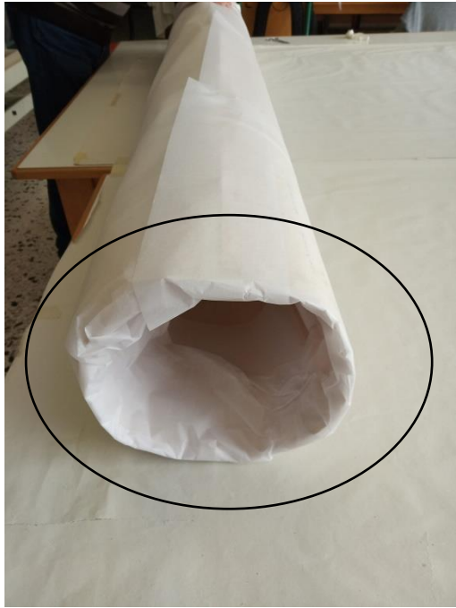
Εικόνα 131. Τα περισσεύματα στις άκρες έχουν τοποθετηθεί στο εσωτερικό του σωλήνα.
